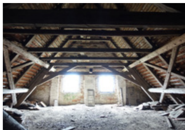
Nahoře: Plná vazba v sev. části; datace úprav (nikoliv vzniku). Dole: Již. štít s datací 1915; zdobné hranění „andělská křídla“.
