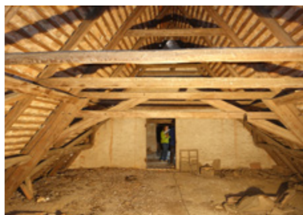
Nahoře: Severní část - nad obytným domem. Dole: Jižní část - nad sýpkou.
