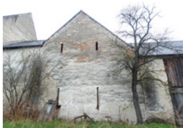
Nahoře: Východní fasáda se zazděným vchodem a druhotně použitým kamenickým materiálem. Dole: Západní fasáda.
