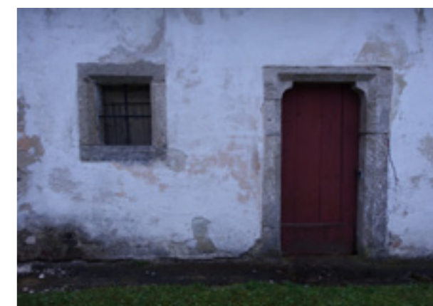
Gotický portál byl v baroku přezděn, západní průčelí nahlíží do dvora fary. Některé gotické prvky mohou mít druhotnou polohu.
