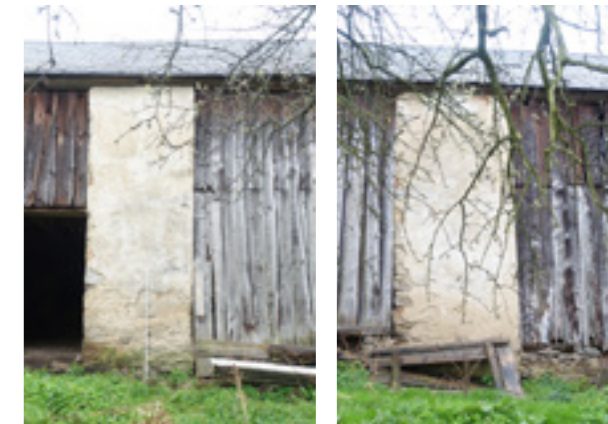
Nahoře: Východní fasáda, napojení zadní stodoly na stodolu. Dole: Západní fasáda s prkennými výplněmi.
