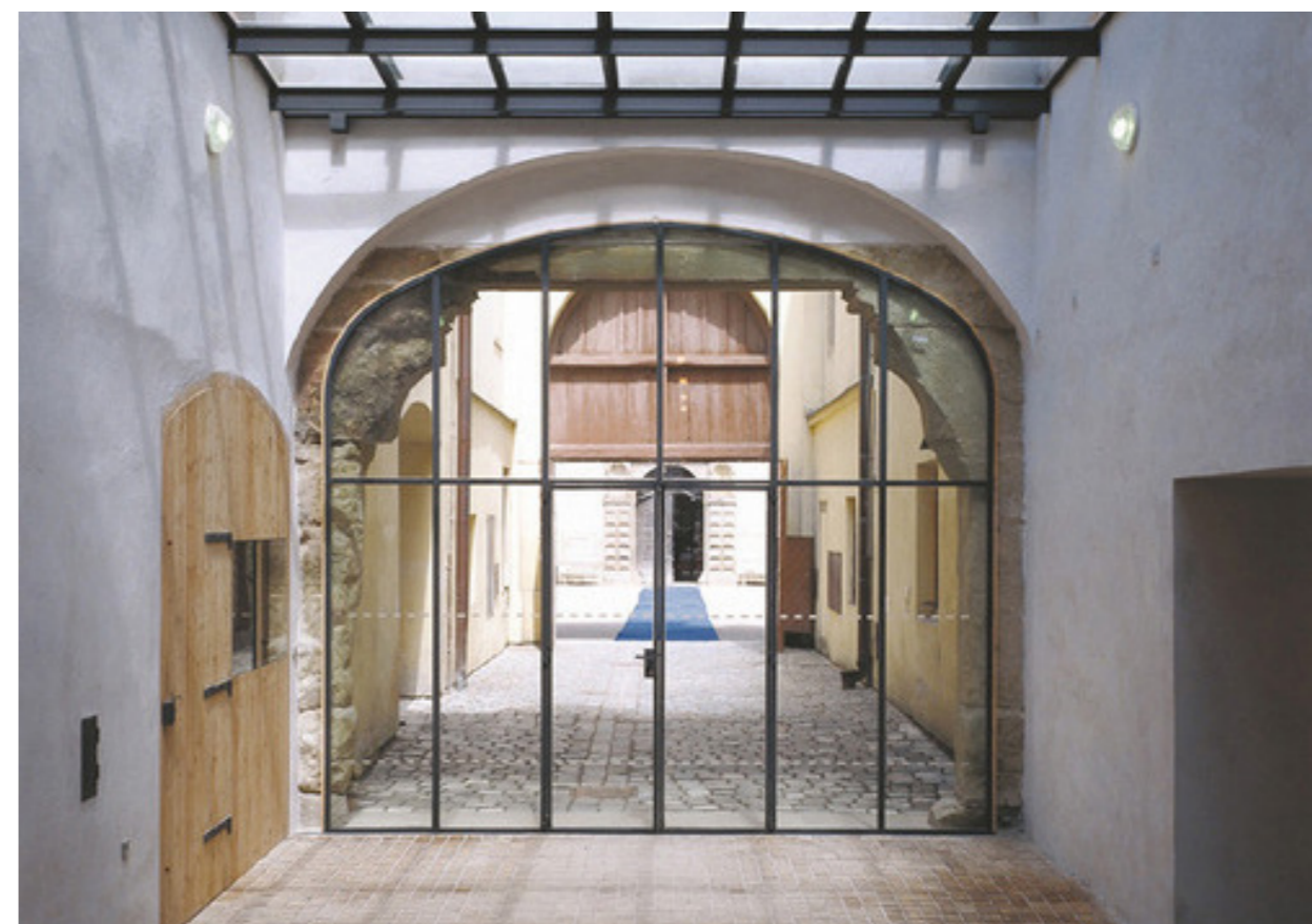
REKONSTRUKCE ZÁMECKÉHO PIVOVARU V LITOMYŠLI AP Atelier - Josef Pleskot - 2006
