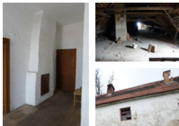
Nahoře: Mnohačetné změny topeniště v přízemí sev. komínu. Dole: Již. komín v chodbě, v podkroví; komíny zleva sev. a jižní.
