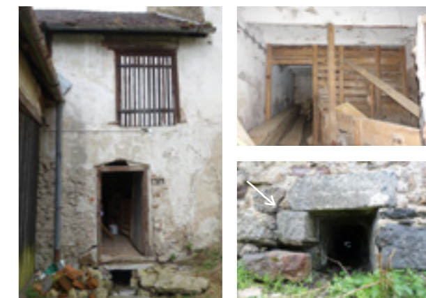
Vlevo: Východní fasáda. Vpravo: Vnitřek chléva; odvodňovací kanálek pod chlévem s druhotně použ. ostěním s polodrážkou.
