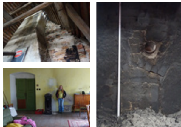
Nahoře: Severní komín. Dole: Topeniště parádní světnice. Vpravo: Zazděný příkládací otvor do kamen parádní světnice.
