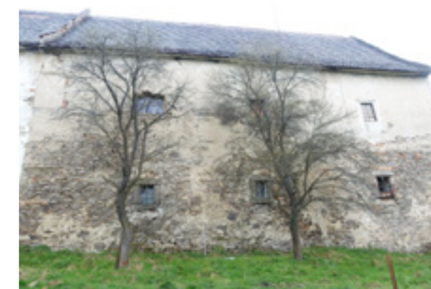
Nahoře: Východní fasáda sýpky. Dole: Západní fasáda sýpky.
