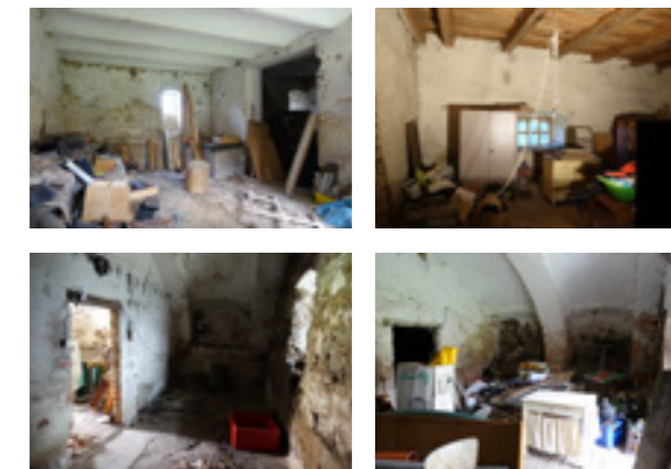
Nahoře: Segmentová klenba v přízemí, trámový strop v patře. Dole: Pruská placca v přízemí sýpky.
