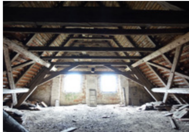
Nahoře: Severní-uliční fasáda fary s barokní bosáží (1988). Dole: Krov s ležatou stolicí nad farou a sýpkou.
