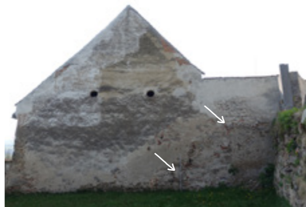
Nahoře: Druhotně použitý kamenický materiál ve vých. štítu; vaznicový krov stodoly. Dole: severní a jižní fasáda.
