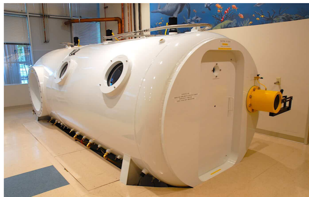
Vícemístná komora http://www.nemocnicekladno.cz/nemocnice/partneri/hyperbaricka-komora
