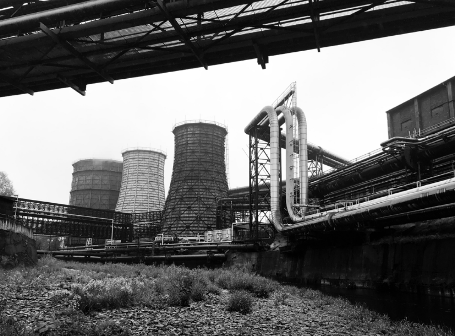
pohled na chladicí věže od řeky Olzy
