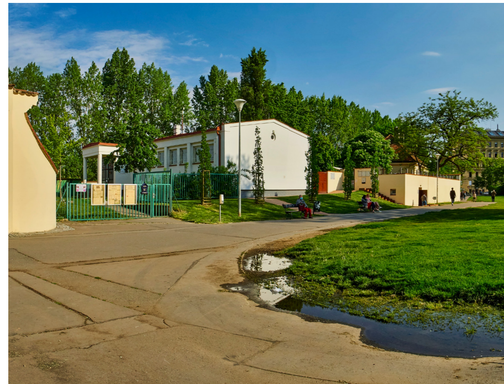
POHLED NA BUDOVU KOMUNITNÍHO CENTRA [14]
