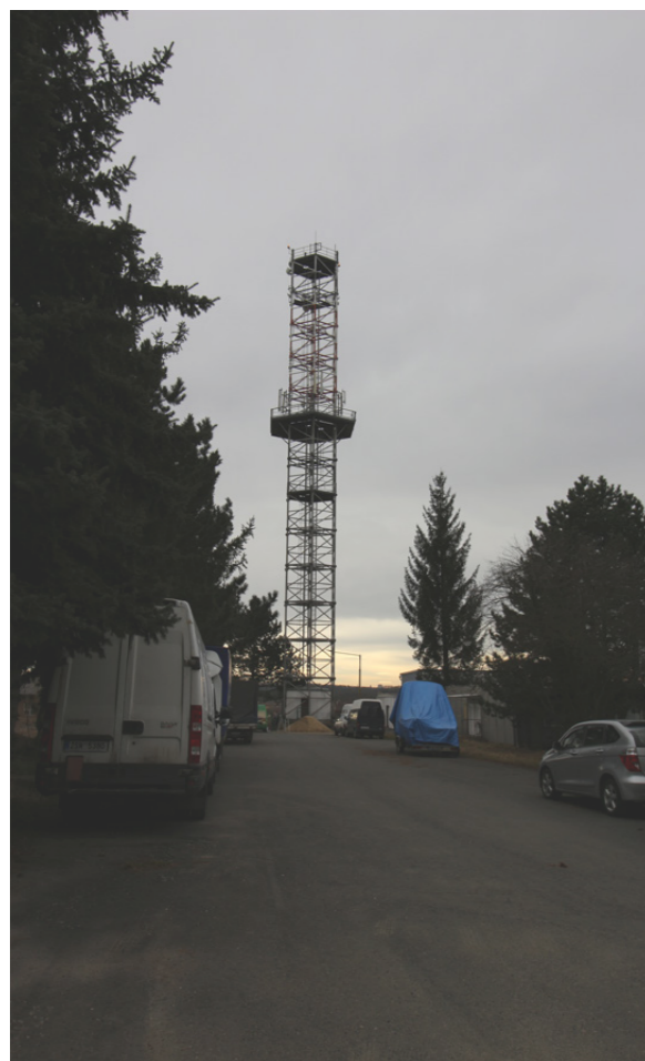
1/ telekomunikační věž ve východní části
