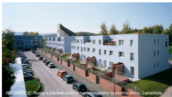
REFERENCE: Terasy a předzahradky rekonstruovaného bytového domu, Leinefelde
