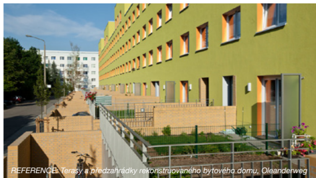
REFERENCE: Terasy a předzahradky rekonstruovaného bytového domu, Oleanderweg
