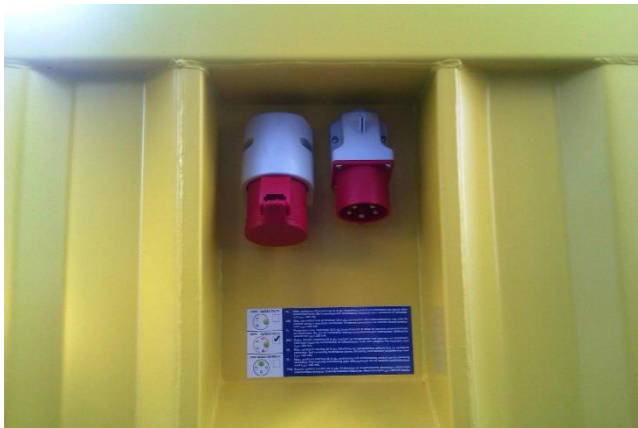
CEE přípojka na kontejnerech
