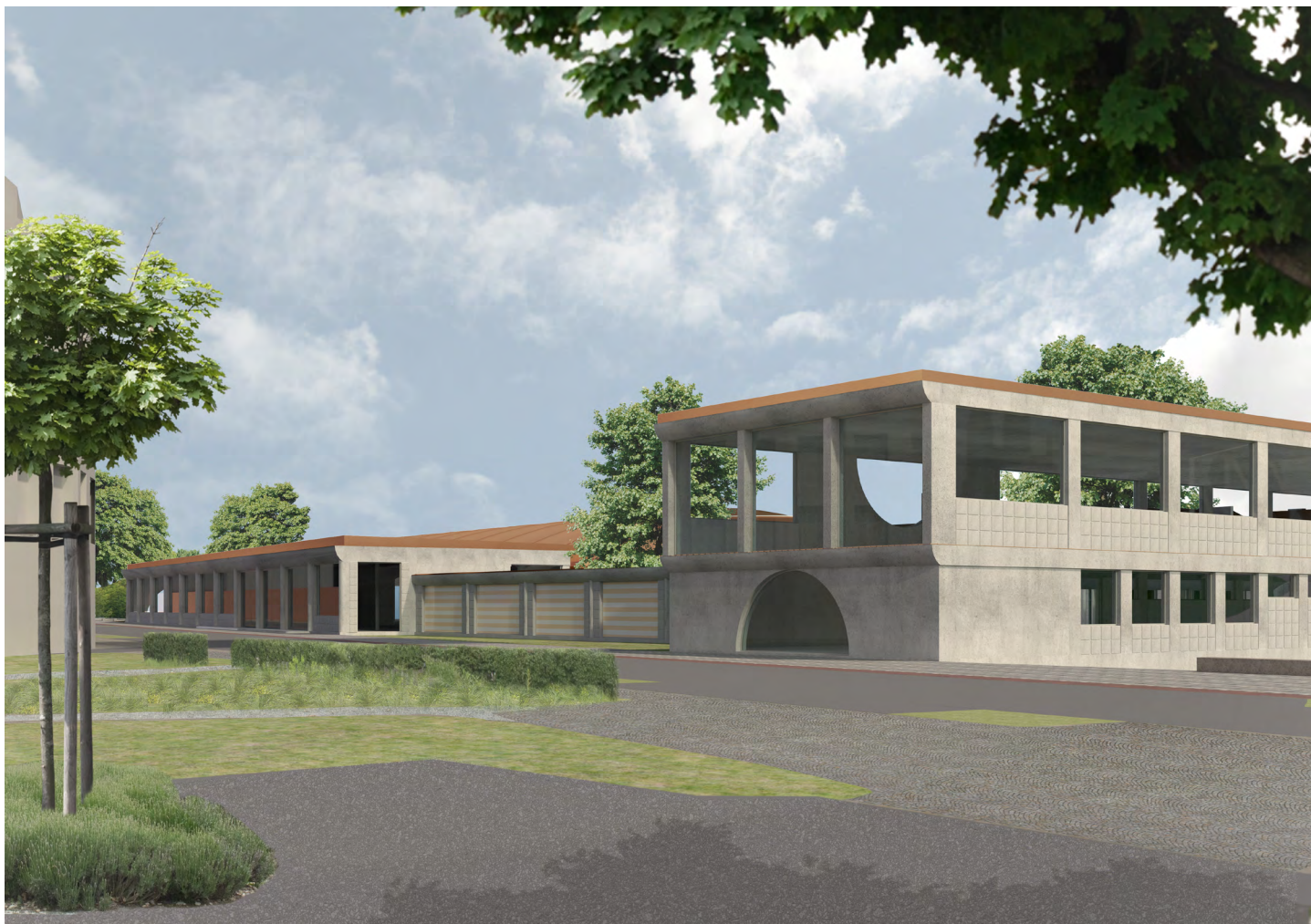
Pohled od Železničního mostu.
