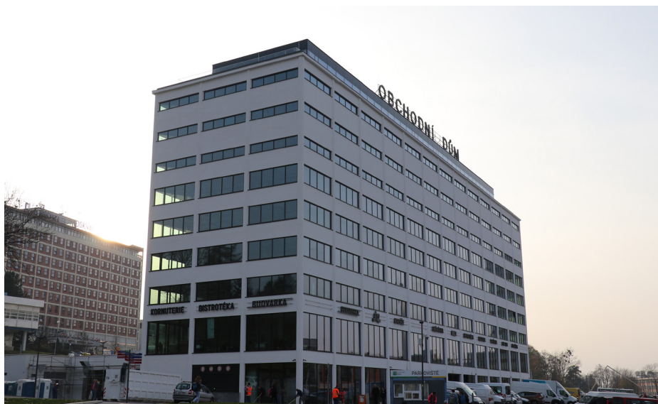
Rekonstrukce Obchodního domu (Jaroslav Ševčík)
