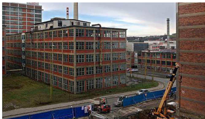
25. budova před demolicí
