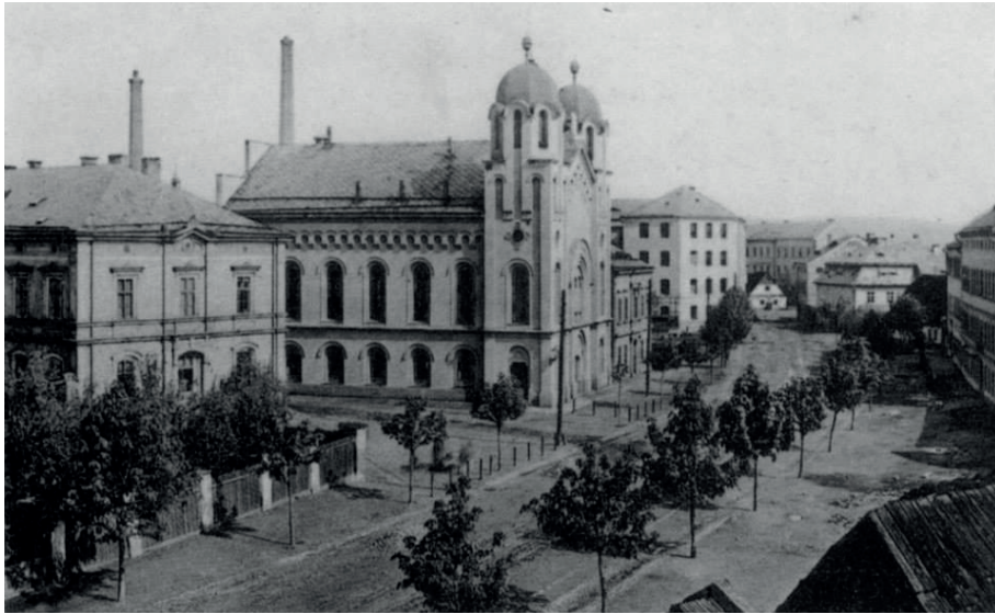
pohled na dnešní Soukenickou ulici - v popředí synagoga se spolkovým domem, za ní továrna Soukenické společnosti před rozšířením [4]
