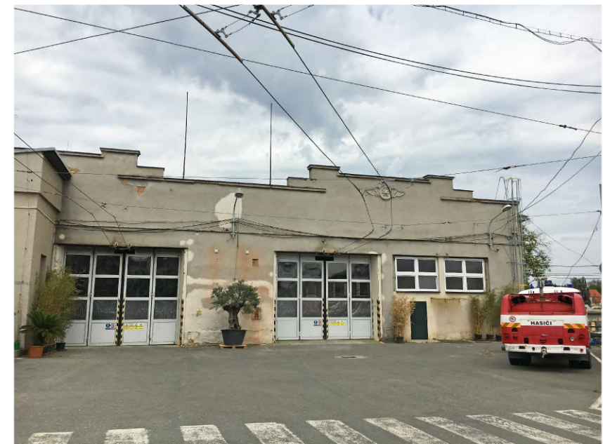
bývalá tramvajová a trolejbusová vozovna historicky první objekt vozovny
