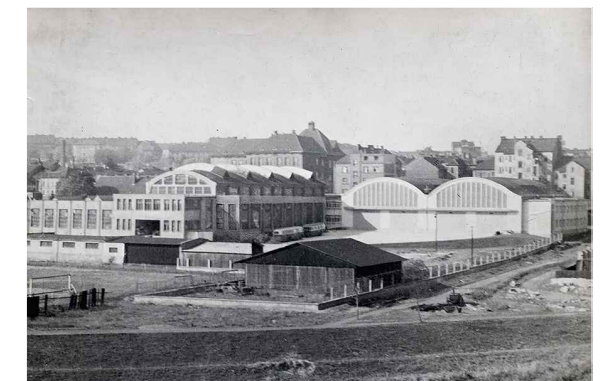
pohled na nové autobusové garáže spolu s ústředními dílny
