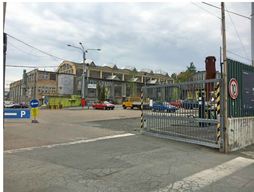
hlavní vstup do DEPO2015
