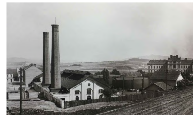
soubor budov městské plynárny v Doudlevcích
