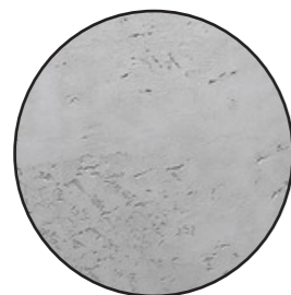
strop - pohledový beton
