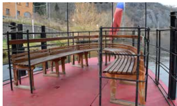
Chybějící výtlač, malá stabilita
