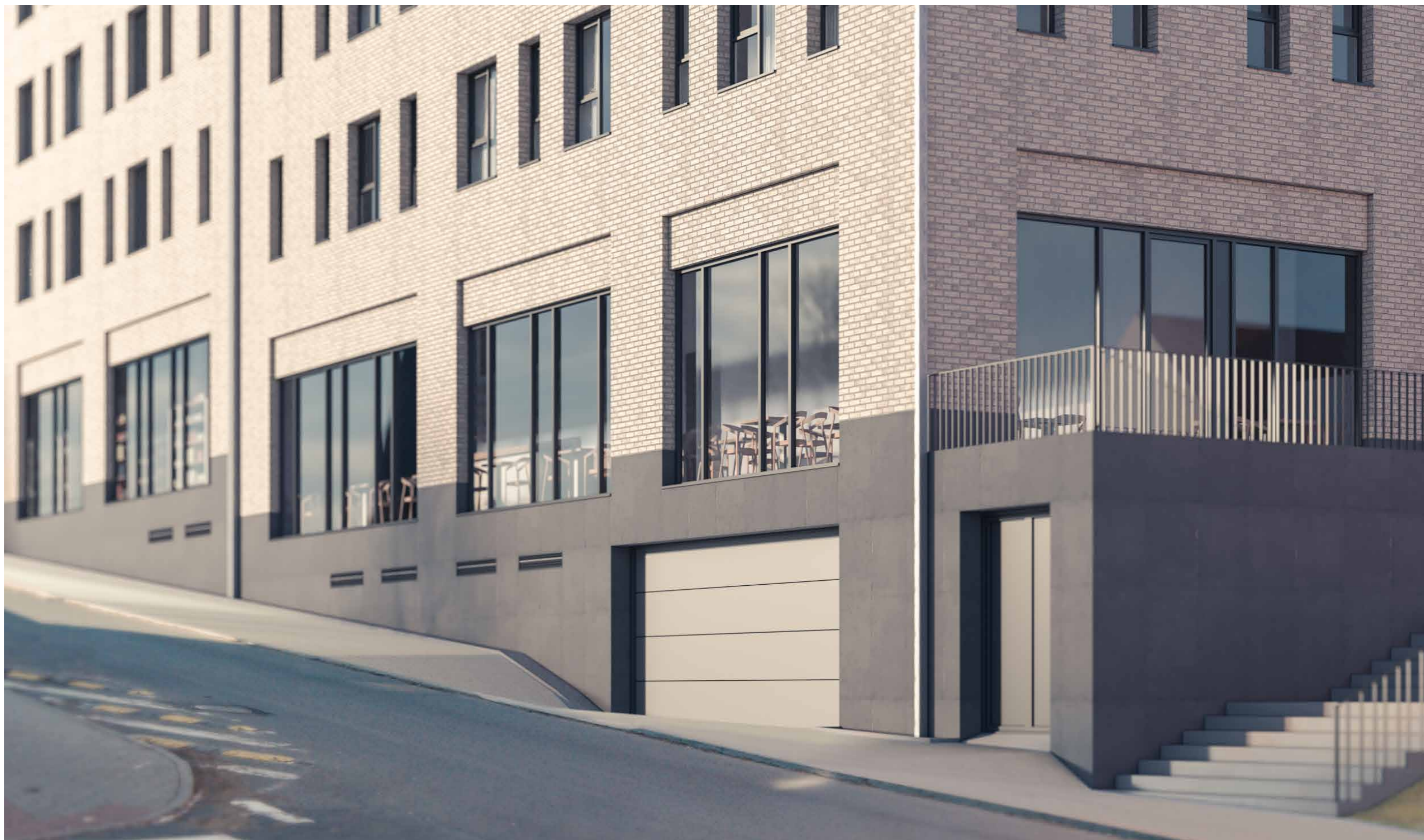
Pohled na parter
