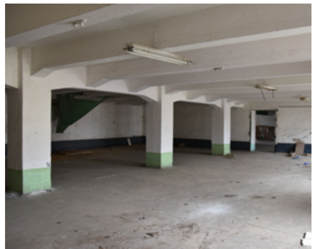
železobetonová konstrukce od 3NP
