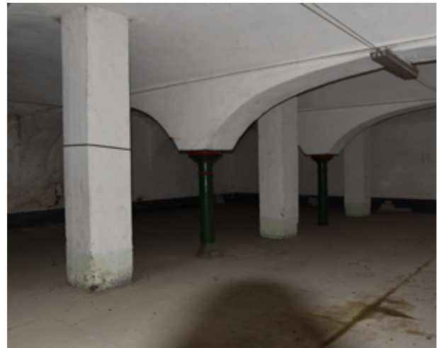
klenutý strop ve 2NP s vyústěním žb sloupů
