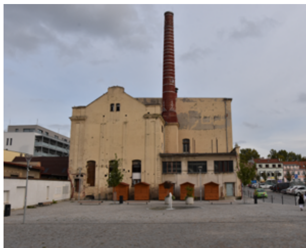
západní průčelí proti kostelu
