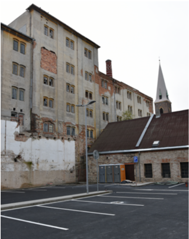
pohled na severní fasádu
