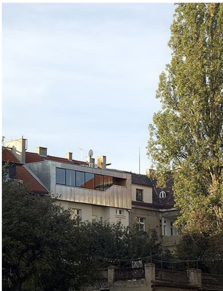
Střešní nástavba Praha Malvazinky
