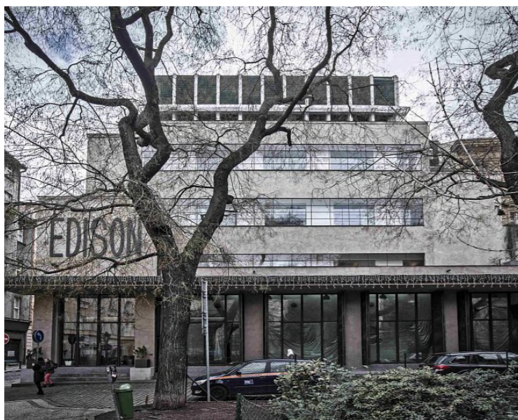
Edisonova transformační stanice
