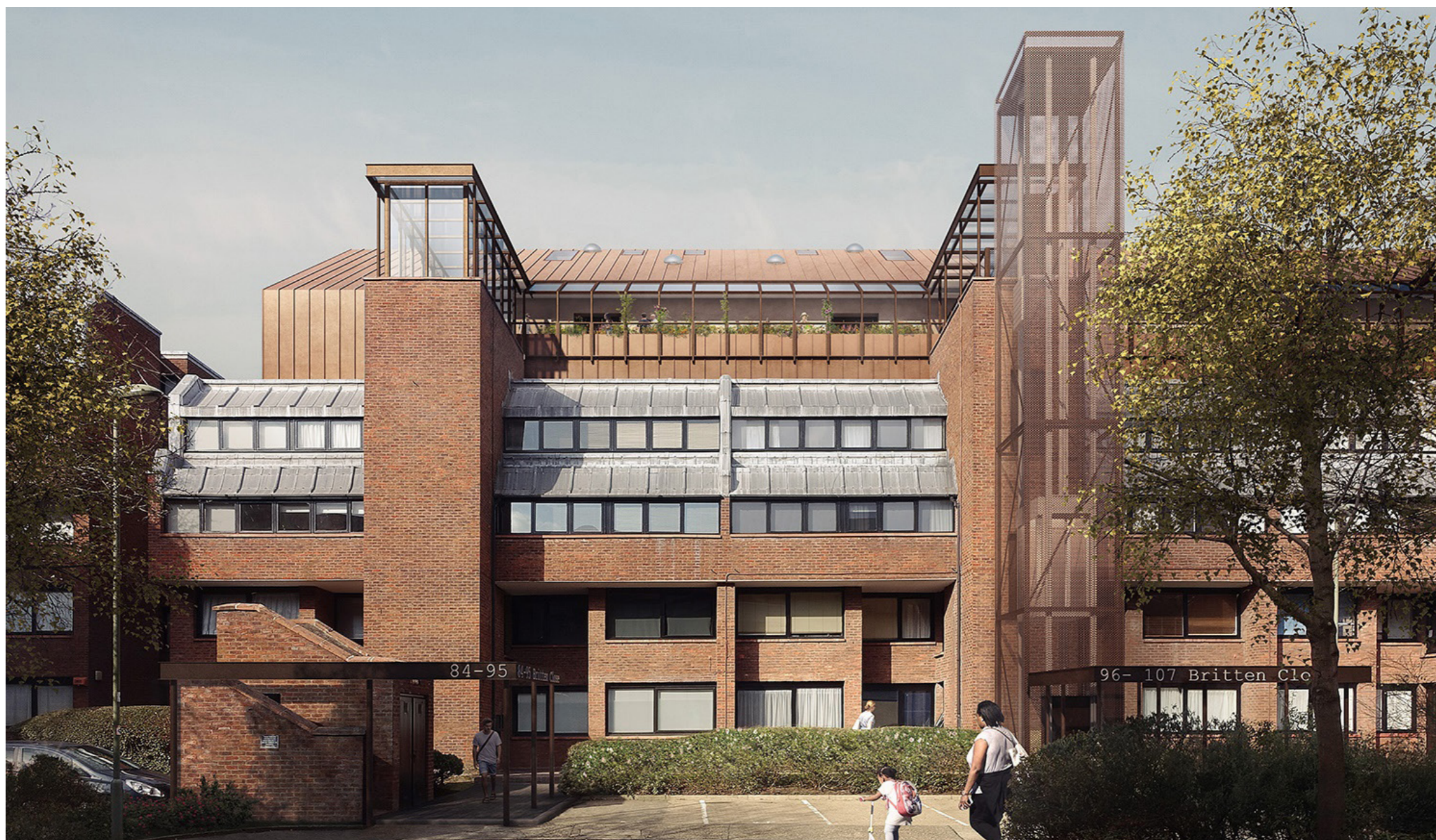
Nástavba 19 bytů rozložených do dvou podlaží a přístupných speciálním venkovním výtahem
