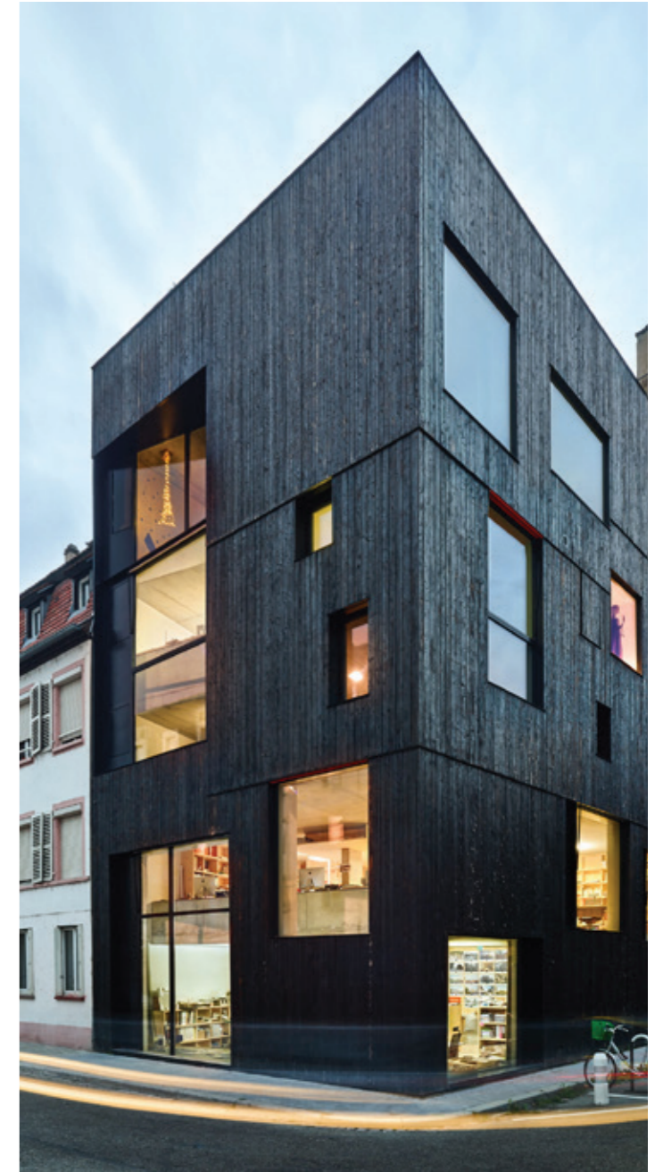
Exteriér (Zdroj: Dominique Coulon & associés)
