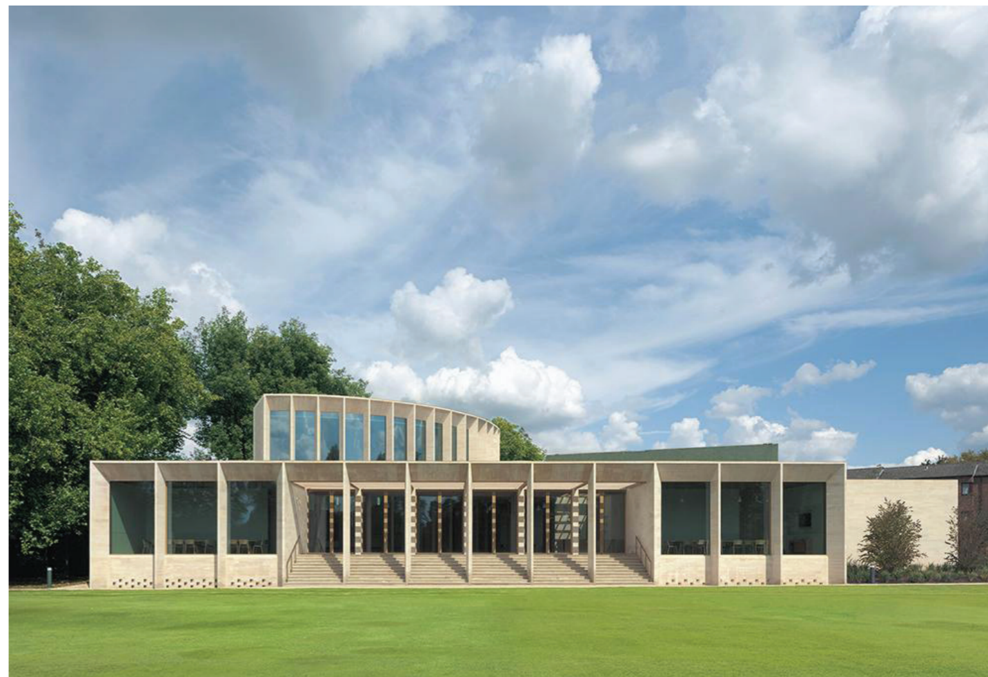
Exteriér ( Zdroj: Niall McLaughlin Architects )
