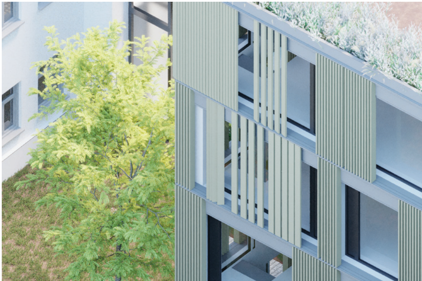
Budova B a C - flexibilní uspořádání a natočení vertikální protislunečních lamel na obvodovém plášti
