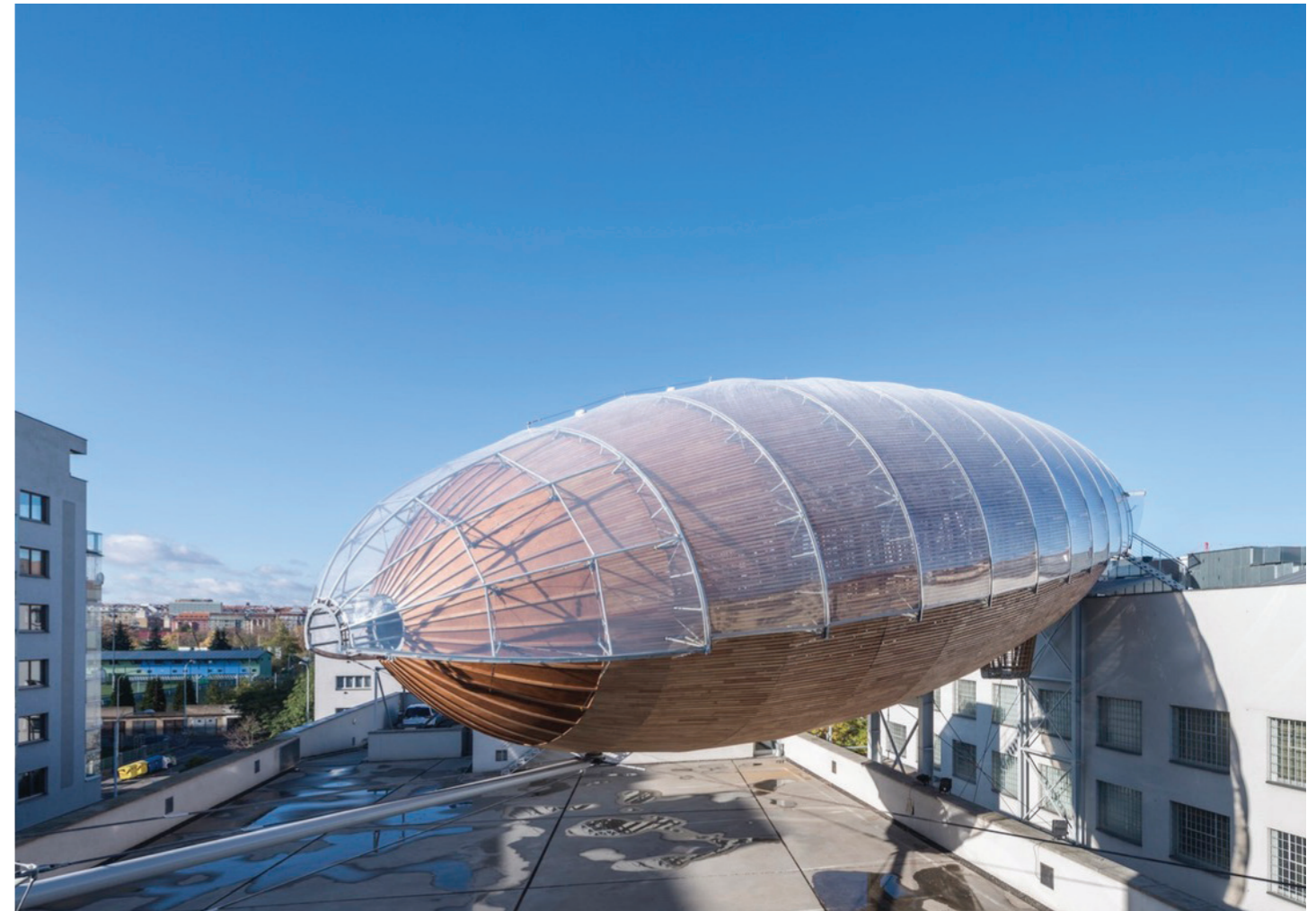
Exteriér (Zdroj: Huť architektury Martin Rajniš)
