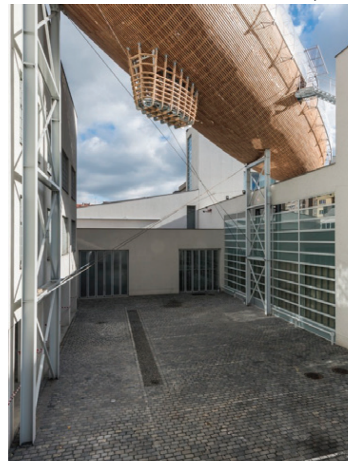
Exteriér (Zdroj: Huť architektury Martin Rajniš)
