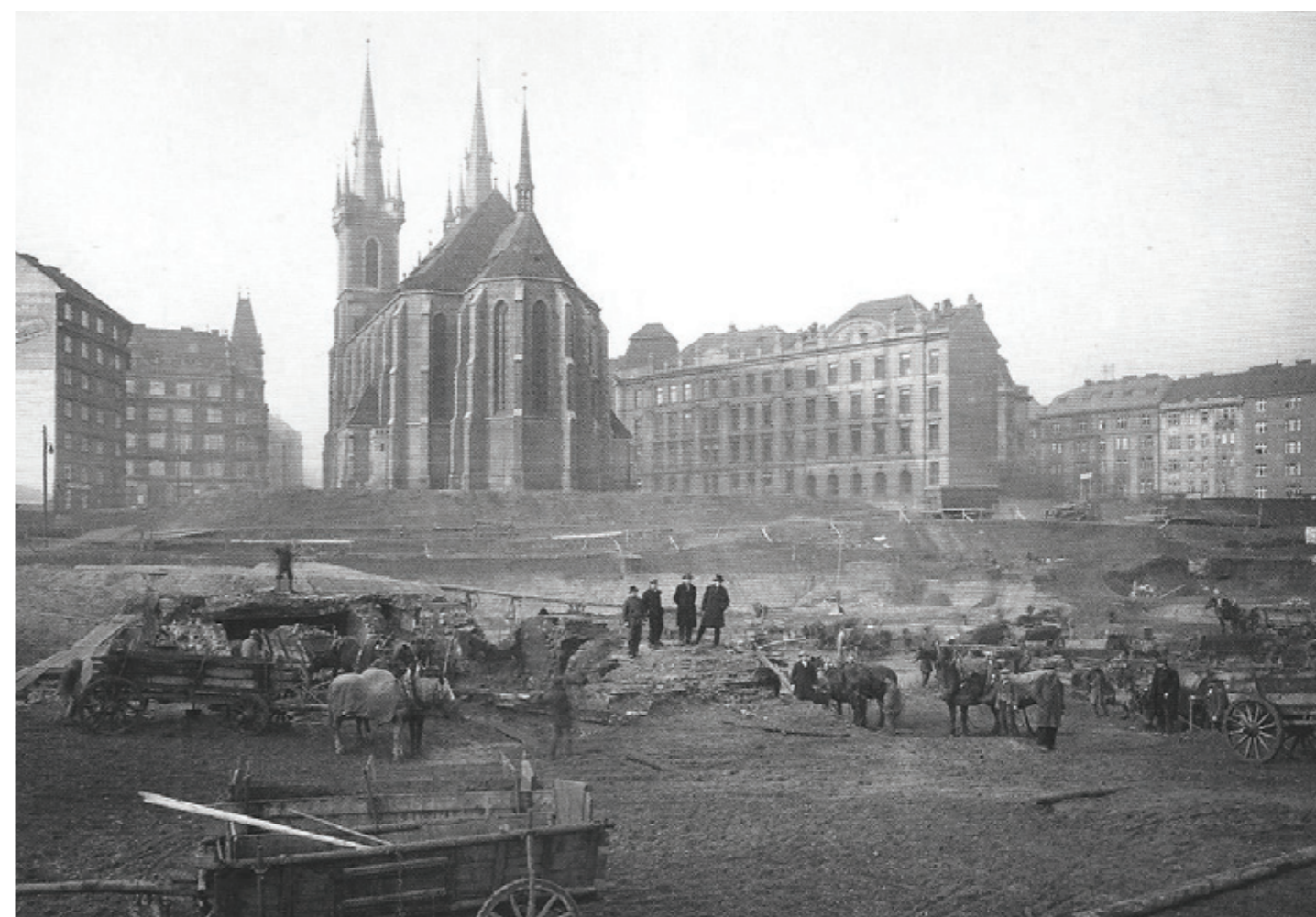
Začátek stavby budovy Elektrických podniků 1927 ( Zdroj: IPR )
