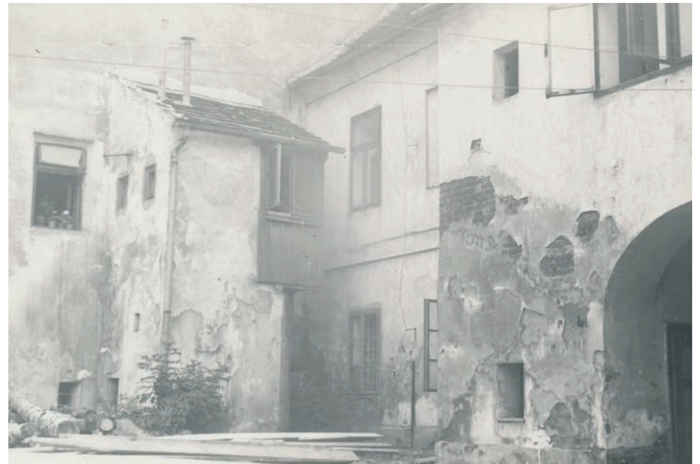
pohled z dvora sousedního domu čp.109 na radnici
