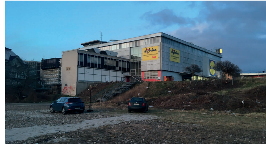
40 | Pohled na OD Lidl (Prior) z přilehlého parkoviště - volného pozemku po demolici Domu kultury Inwest.
