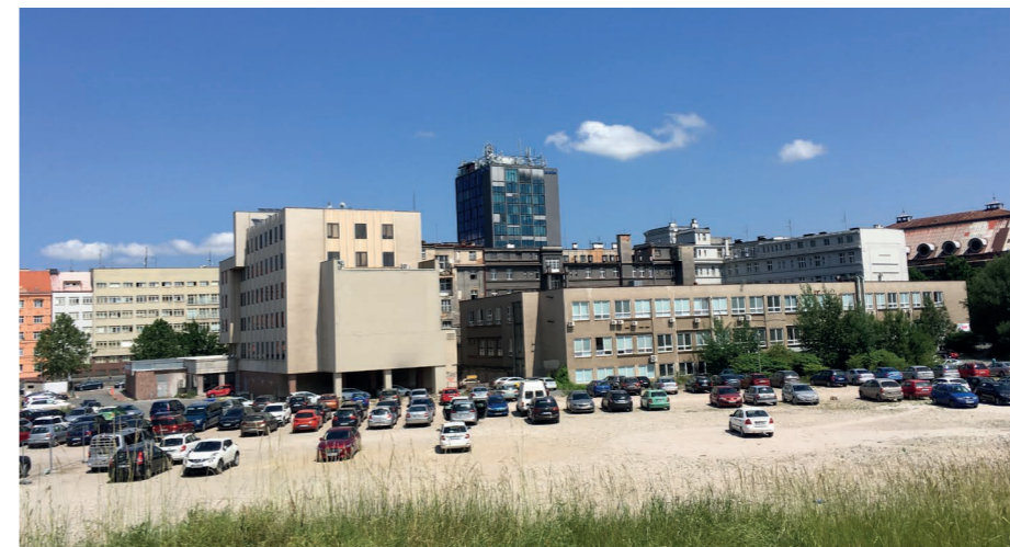
42 | Pohled z Americké třídy na parkoviště - volný pozemek po demolici Domu kultury Inwest.
