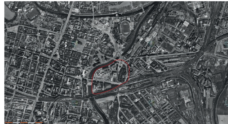
31 | 1982 Je zde zachycena příprava průtahu - rozestavený nový Tyršův most, zničení prostoru U Jána, obchodní dům Zdroj (Prior) a rozestavenost kulturního domu Inwest.
