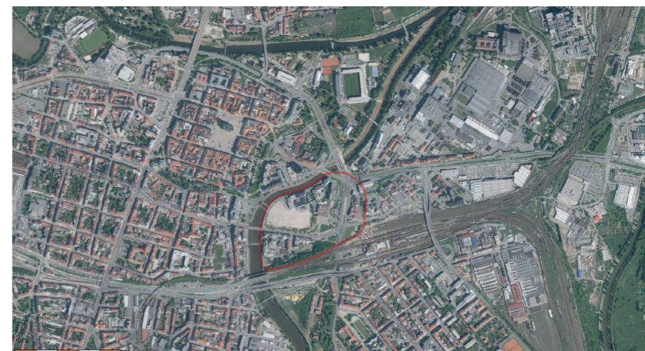
33 | 2013 Volná plocha po zbourání Domu Hrůzy na níž nemohl být zrealizován původní záměr dodnes čeká na lepší využití. Do té doby je využívána jako parkoviště.
