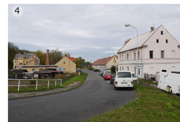
4. současný stav staré školy, v popředí je nájezd na silniční most
