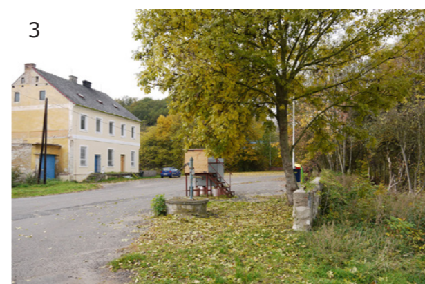
3. pohled na budovu bývalého hostince přes "druhou návěs", skrze kterou dříve vedla silnice do Žatce
