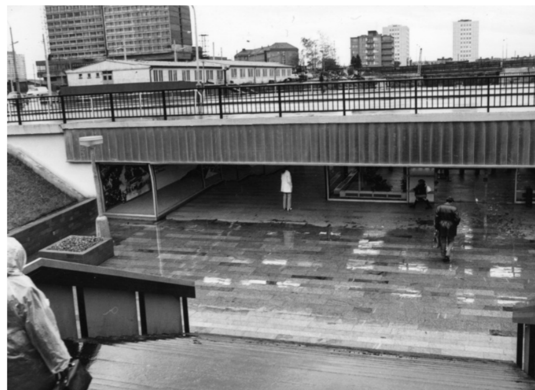
Severozápadní vstup do metra
