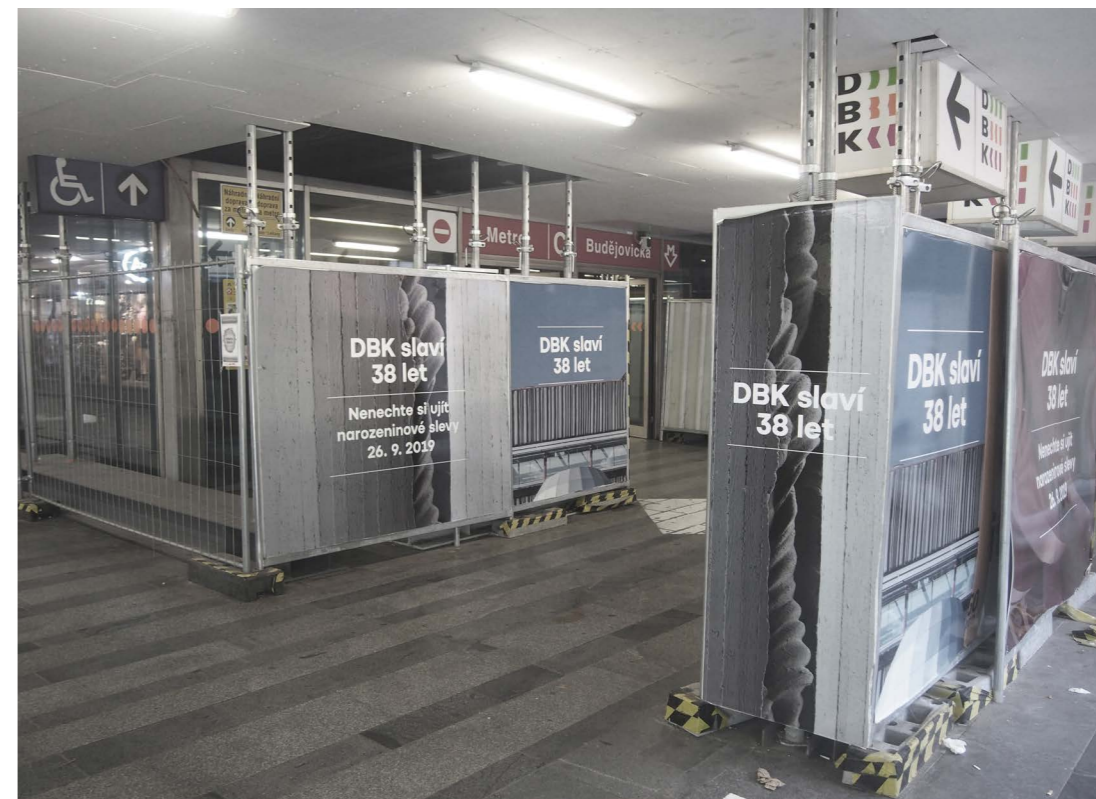
Provizorní zajištění nosných konstrukcí podchodu
