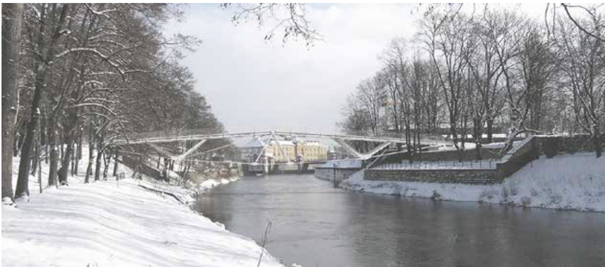
Obr. 10 Lávka přes řeku Orlice, Baum Baroš, 2012
