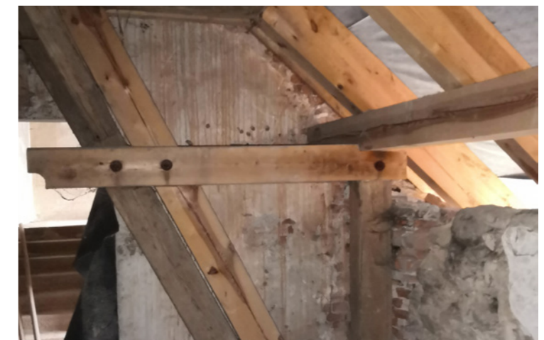
Oprava a nahrazení starých částí kravů.
