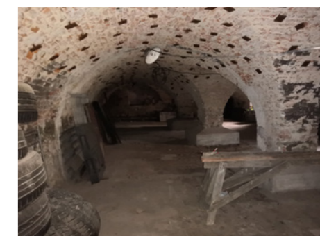
Radnice - sklepní prostory
