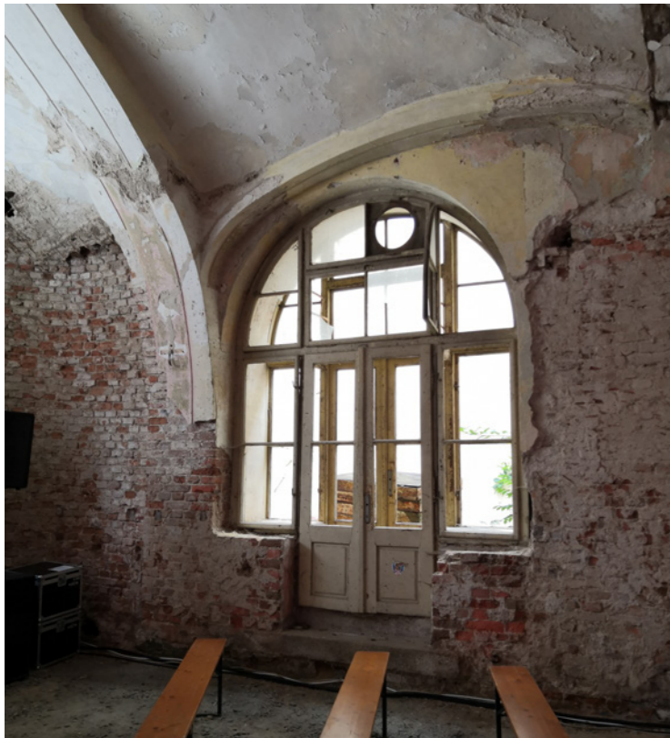
Zachovaná dřevěná okna s čistou výplní v přízmiím hlavním sále radnice.
