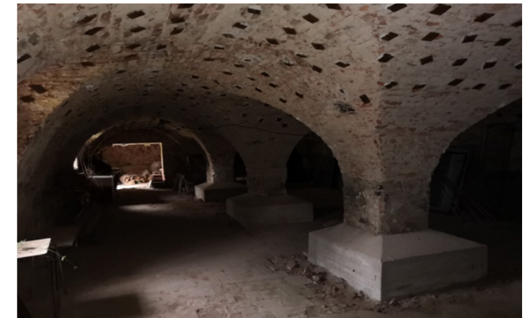
Statické zajištění sloupů a kleneb v části pivovaru.
