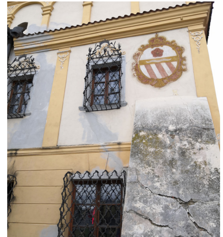
Štuková vysprávka prasklin na čelní fasádě radnice.
