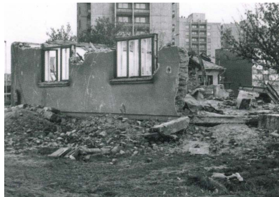
Výstavba v Orlové-Lutyňi v roce 1978 a bourání domu Jana Gabzdyla
