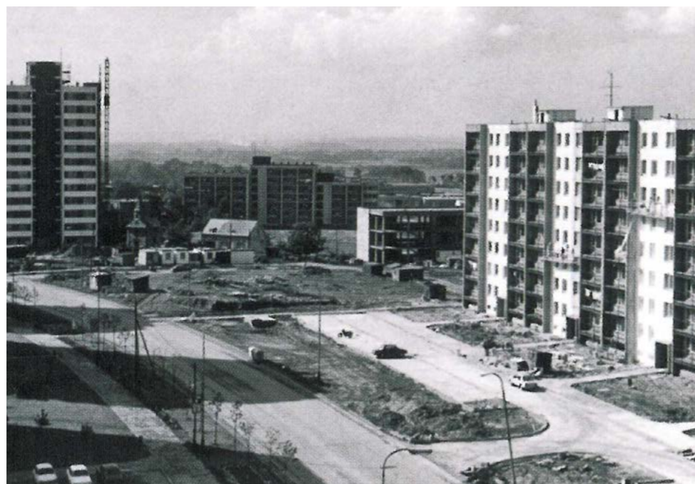
Výstavba 3. etapy v Orlové-Lutyňi
