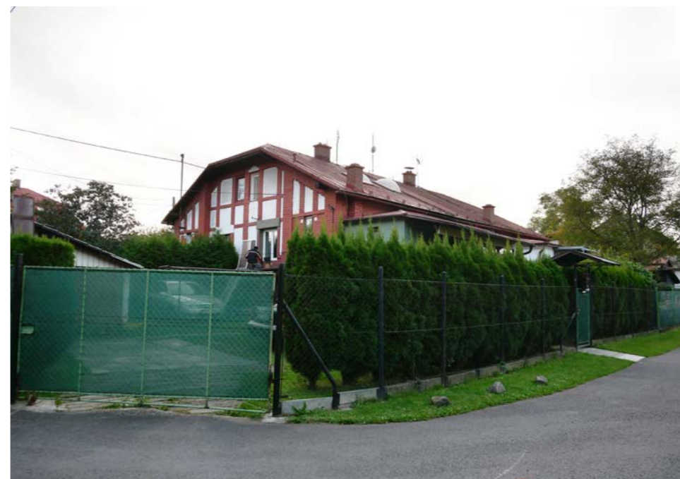
Bývalá hornická kolonie v Porubě v ulici Lipová
