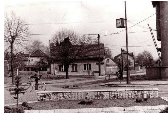
Pohled z ulice Palackého ke škole. V 80. letech byly Dobřichovice ještě vesnicí.
