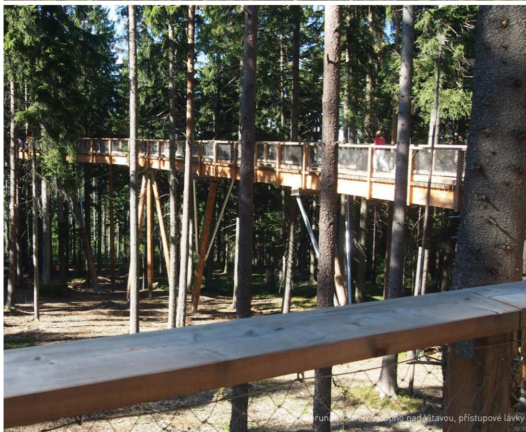
Stezka Korunami stromů, Lipno nad Vltavou, hlavní vyhlídková věž
