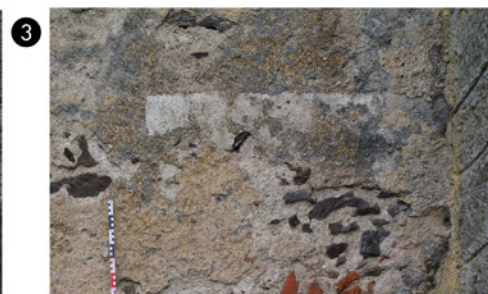
Barokové pásy. šírka 200mm
