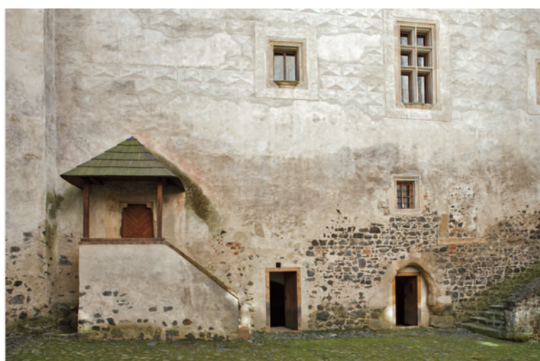
Vzor prístupu k obnove fasády, stret viacerých vrstiev, Švihovský hrad.
