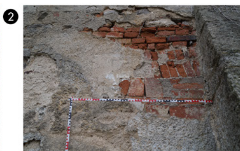
Pasparta zamurovaného okna. šírka 170mm
