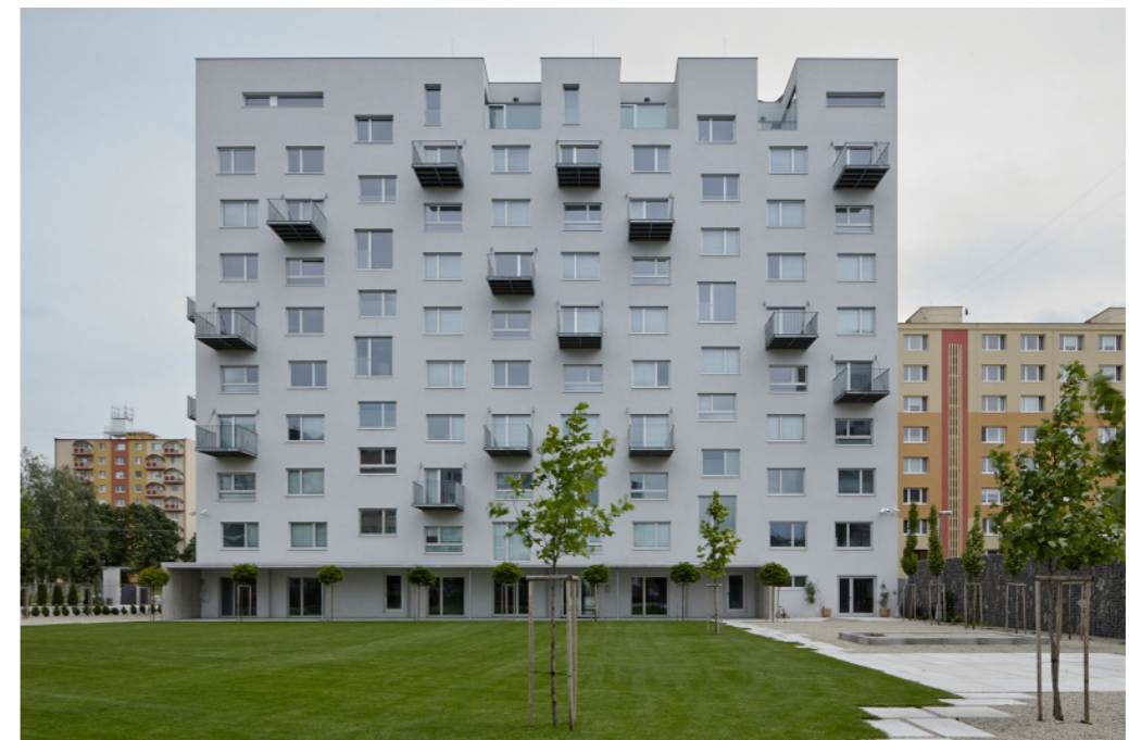
panelák GutGut původní stav stav po rekonstrukci
