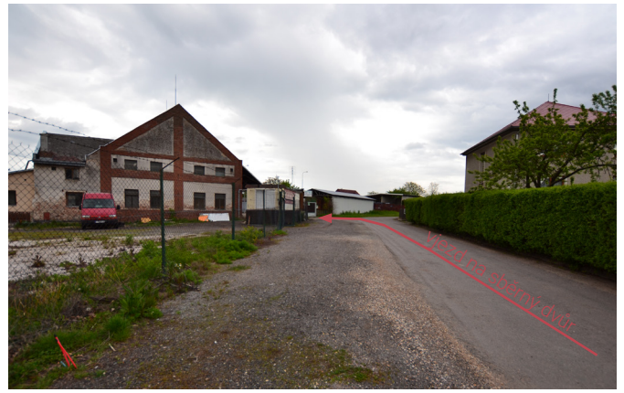
sběrný dvůr, budova technických služeb a bývalý autobazar
