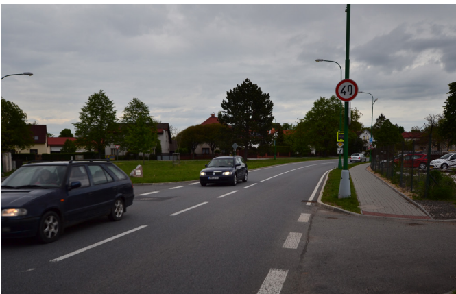
dopravní situace a průjezd obcí
