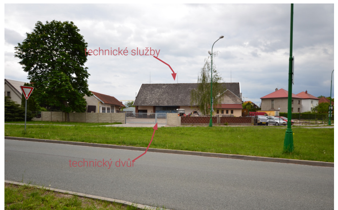
budova technických služeb s technickým dvorem
