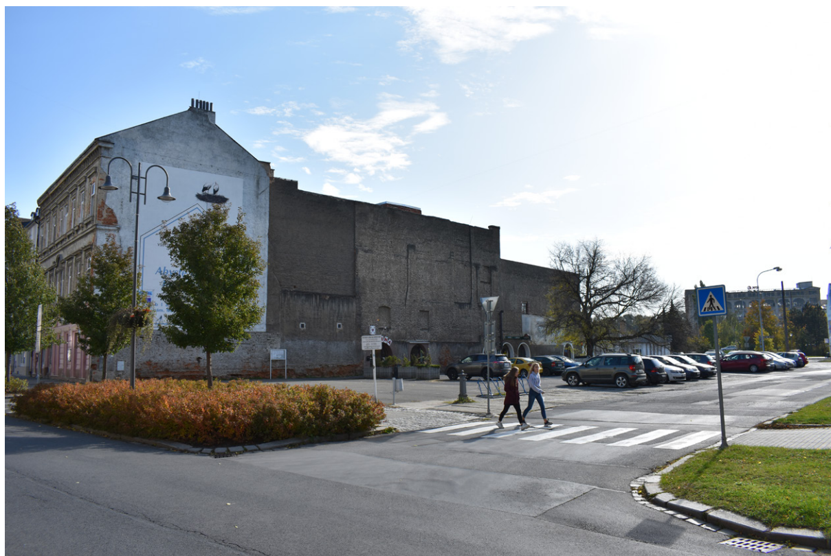
[25] Pohled slepé štítové stěny domů
