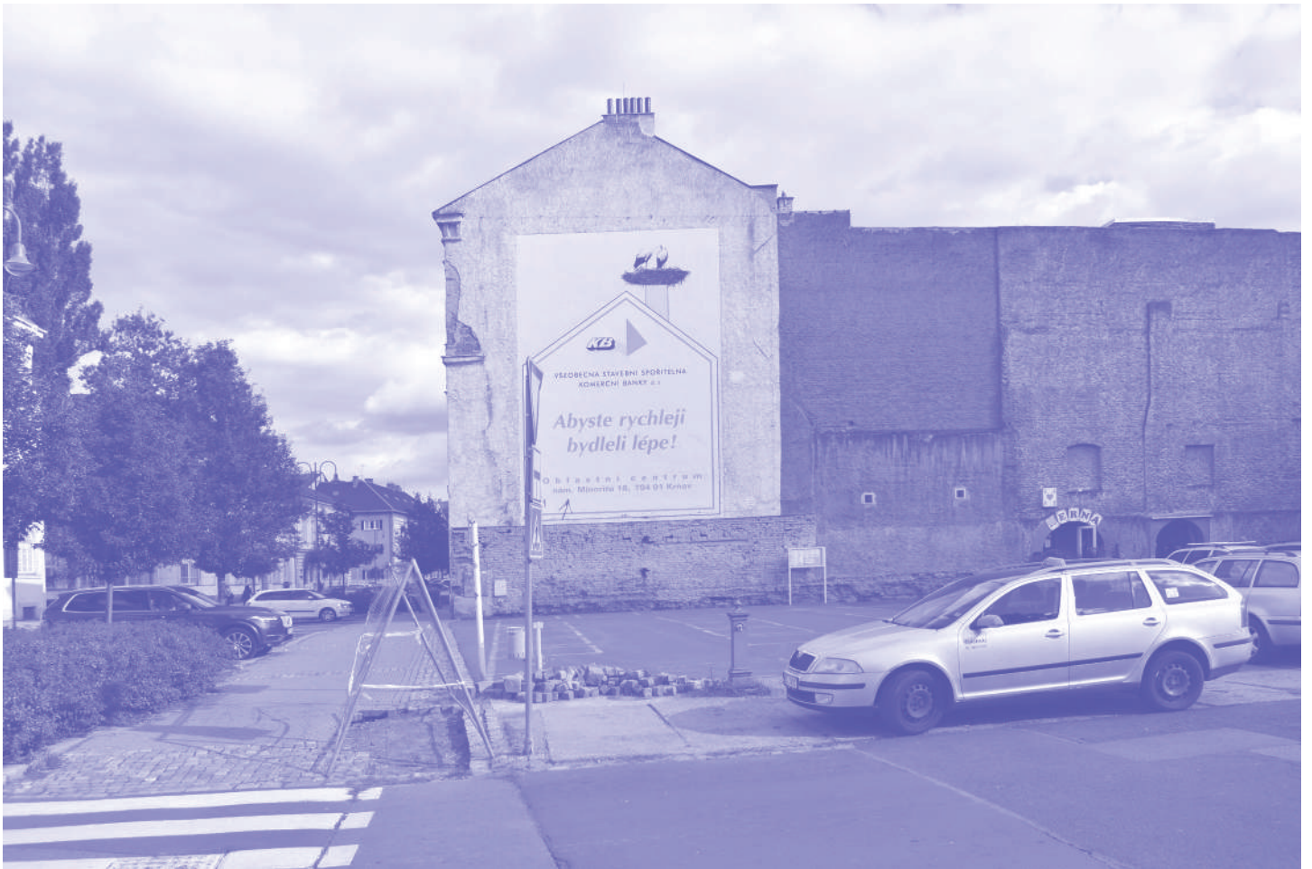
pohled na východní slepý štít
