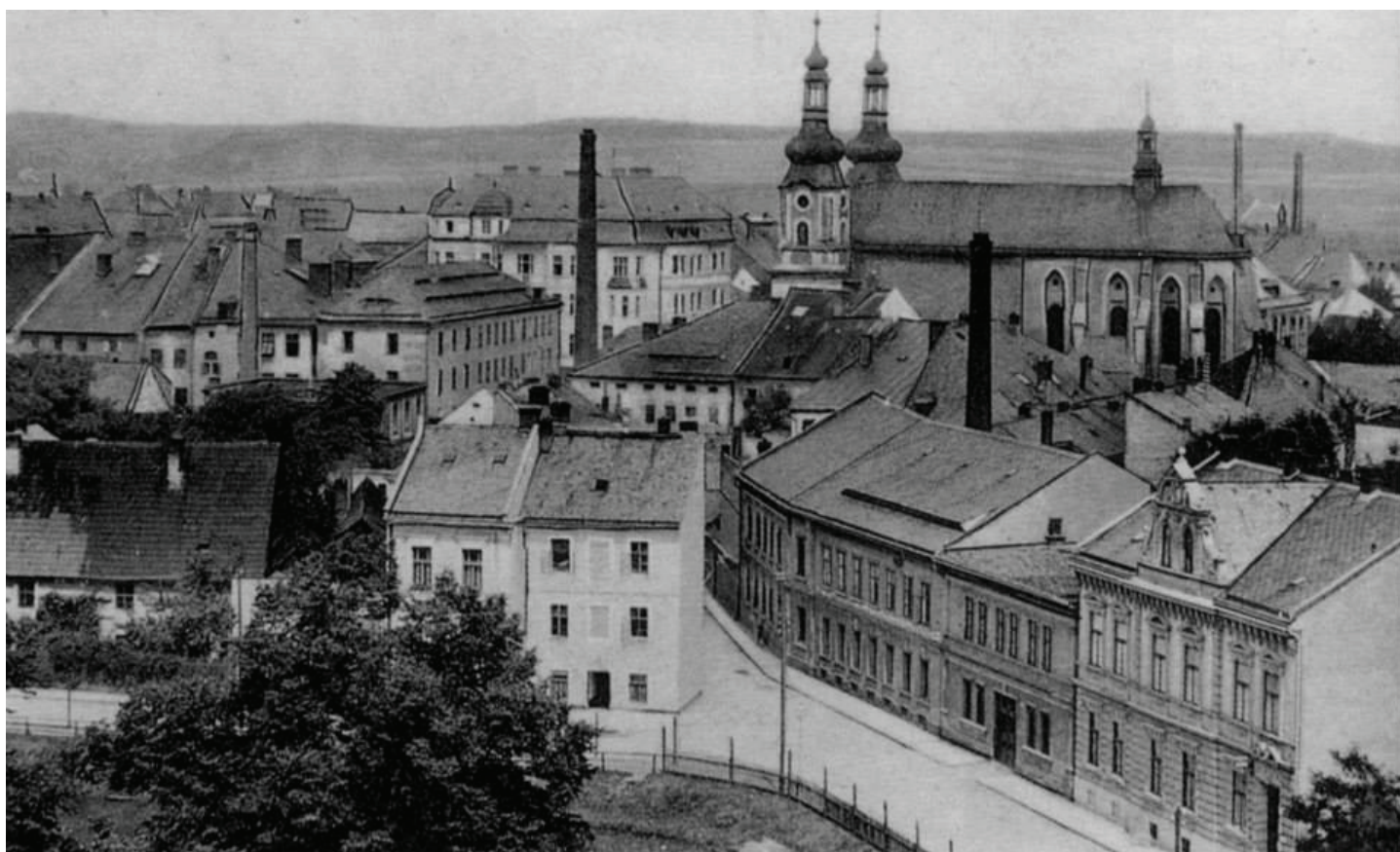
pohled na kostel Minoritů [14]
