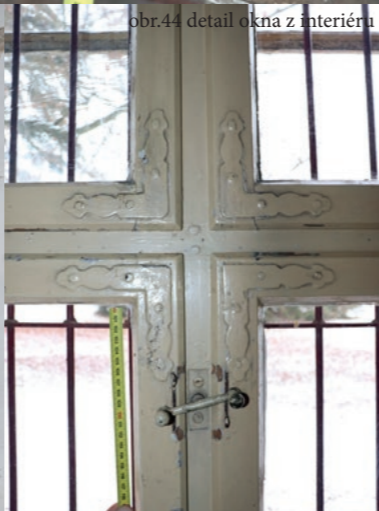
obr.44 detail okna z interiéru
