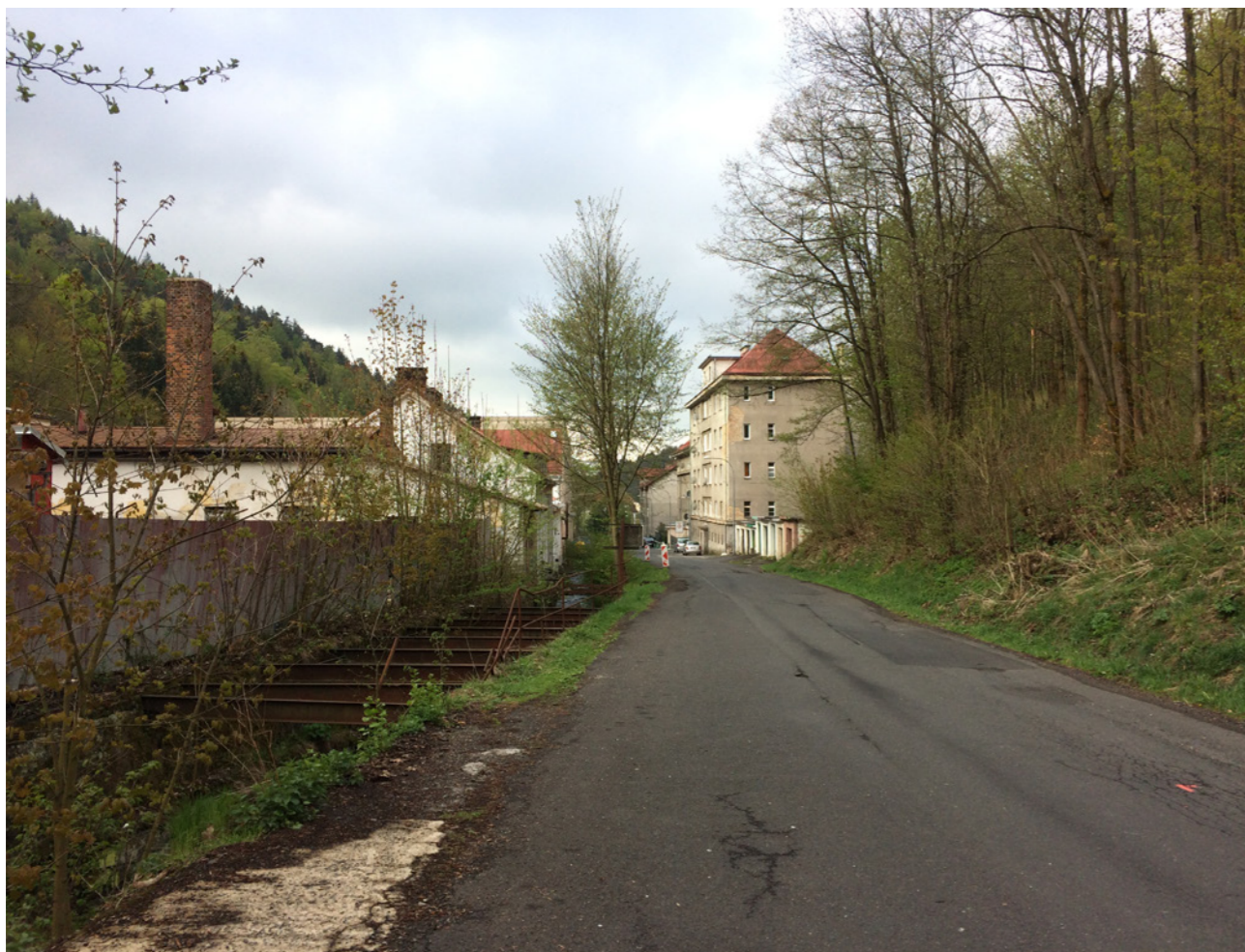
Zástavba v údolí Klínoveckého potoka - bytové domy (opuštěné), továrny, sklady
