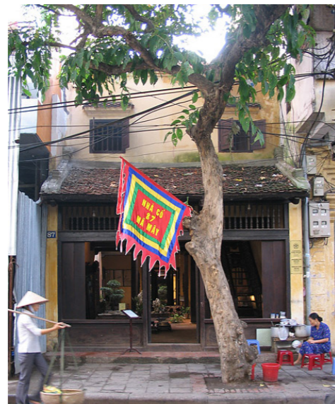
Obr. 41 Pohled z ulice
