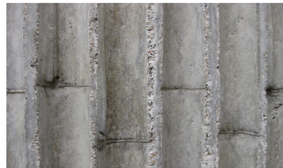
Obr. 53 Betonová fasáda z bambusového lešení
