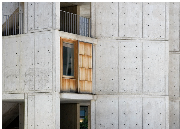
obr.28 Pohľadový betón na fasáde
