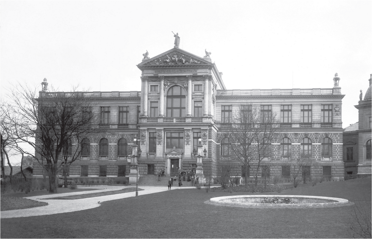
obr.3 Hlavná budova v roku 1902, ešte s kaviareňským pavilónom
