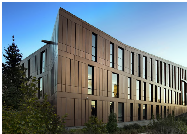
obr.26 Anodizovaný hliník na fasáde
