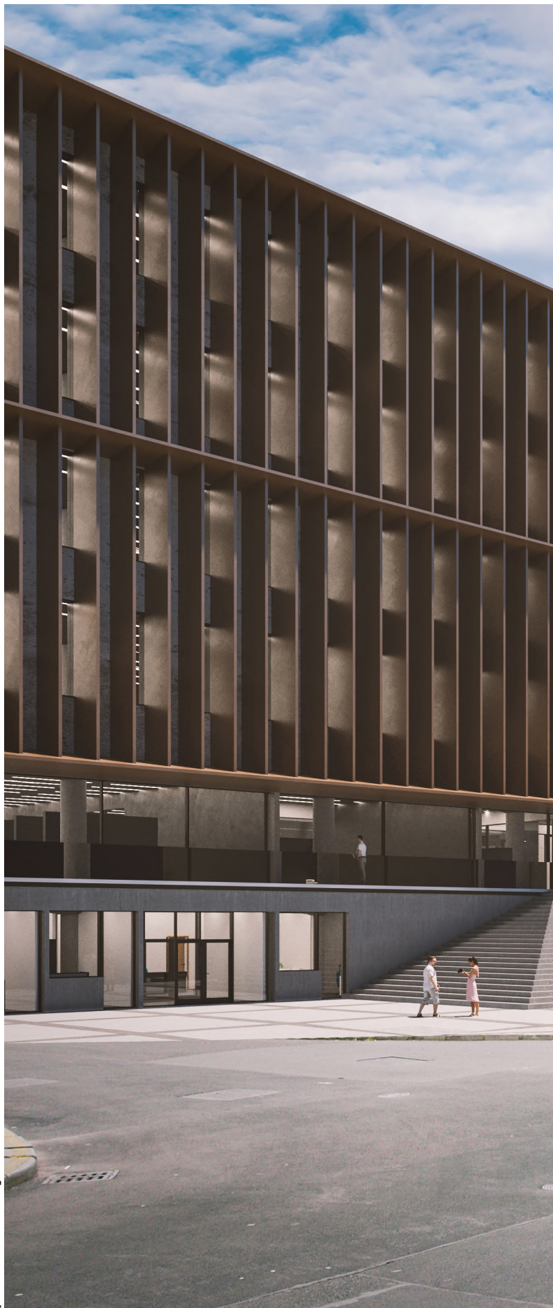
pohľad na hlavný vchod z ulice Tešnov
