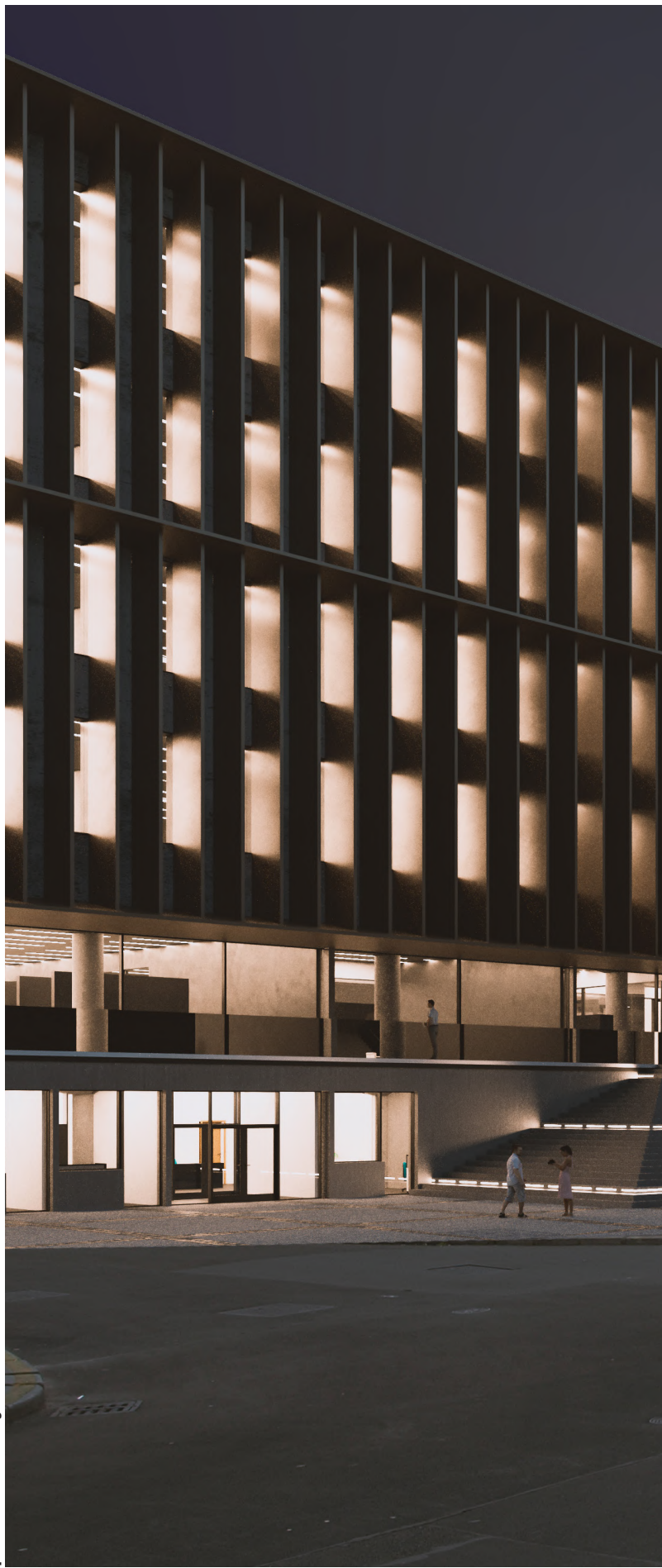
pohľad na hlavný vchod z ulice Tešnov
