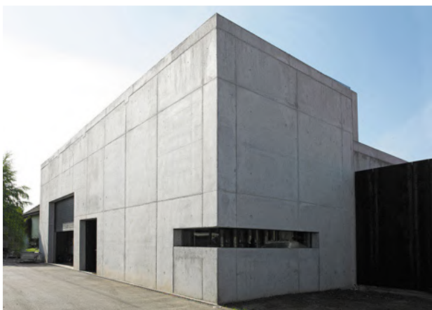
obr.27 Pohľadový betón na fasáde
