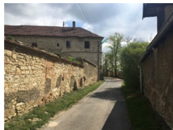
Hodnotný historický ráz ulice Pod Zámkem vyžaduje jen akupunkturní zásahy.
