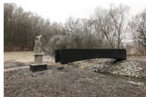
Reference pro novou lávku - Lávka přes Dřetovický potok, autor AOC. Zdroj: http://www.aoc.archi/cs/projekt/5/lavka-pres-dretovicky-potok
