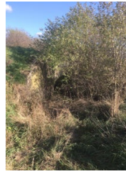
Ústí retenčního prostupu bude zbaveno náletů, líčové kamenné zdivo bude sanováno. Výška prostupu je přes 2,5 metru, šířka 1,2 metru je dostačující.
