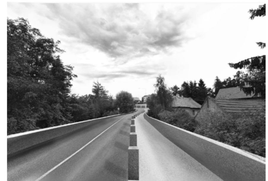
Těleso silnice 240 v údolní nivě. Viadukt je nepatrně rozšířen tak, aby mohl být zřízen průběžný chodník. Dílo bude řešeno jako novostavba se zachováním historických kvalit.
