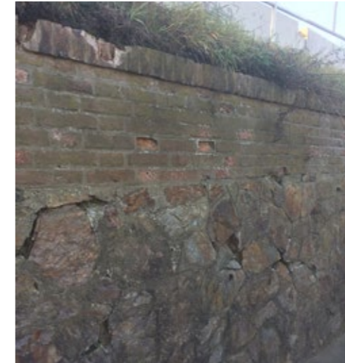
Preciznost původního zdiva viaduktu je při rekonstrukci hodná inspirace.
