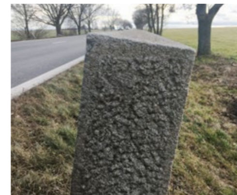
Žulové patníky, které se dochovaly po celé délce silnice budou přeneseny na viadukt v Černém Volu.
