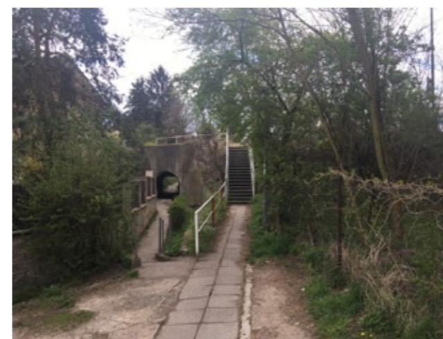
Jediný přístup pod viaduktem, vpravo příkré schodiště zpřístupňující autobusovou stanici části 1.
