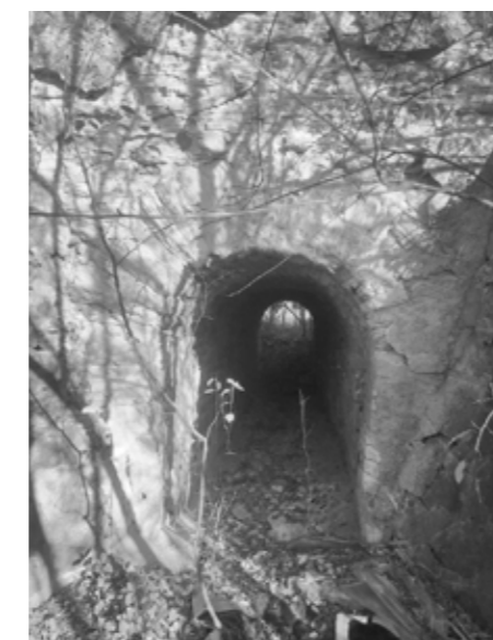
Ústí retenčního prostupu bude zbaveno náletů, líčové kamenné zdivo bude sanováno a bude zvýšena světlá výška snížením úrovně terénu v prostupu.
