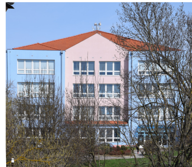
Výhled ze zámku na budovu školy
