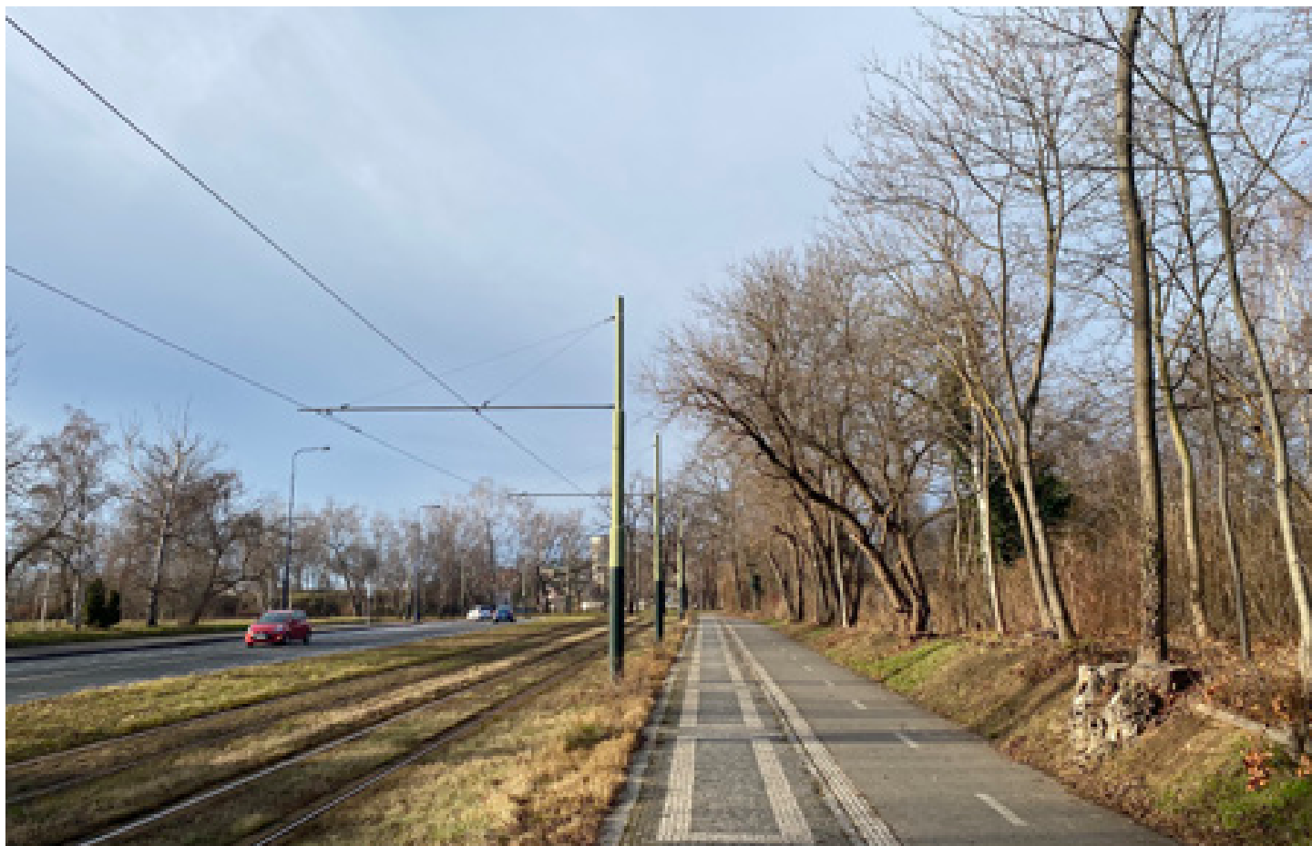
Pohled od tramvajové zastávky Bruska k parku u Kamenného bastionu
