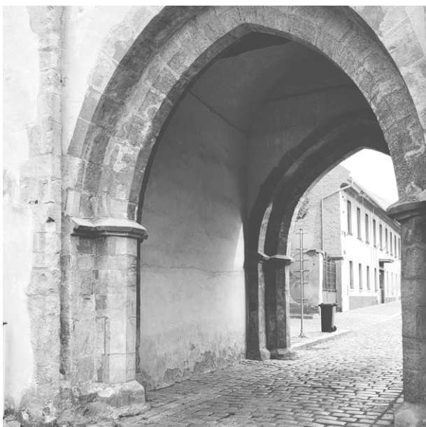
>pohled průjezdem od severu s detailním pohledem na vnější ostění průjezdu...
