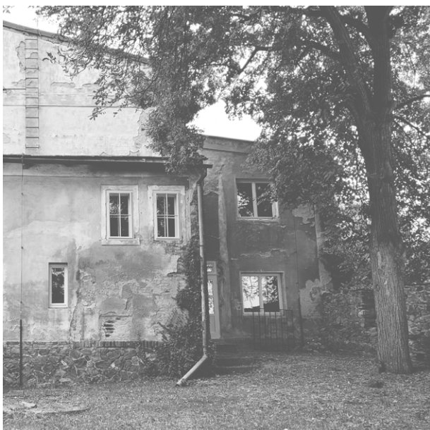
> pohled na fasádu KD Střelnice ze zahrady mezi hradbami (parkánu) na přístavby kotelny a zázemí ochotníků...
