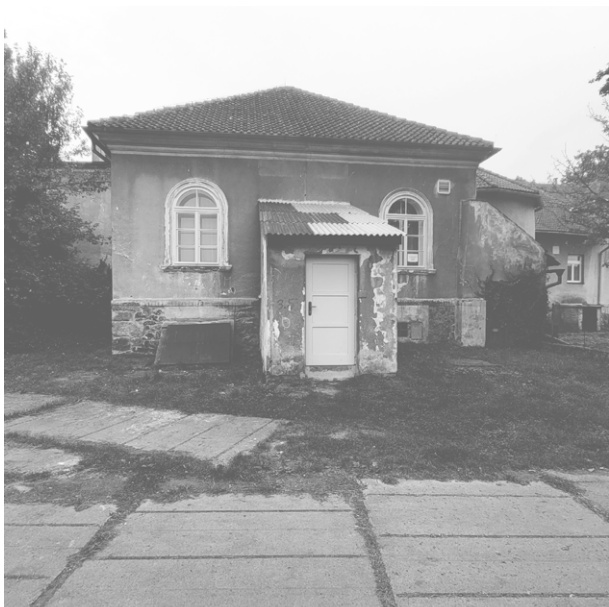
> pohled od jihu (ul. Okružní) na fasádu tanečního sálu s přístavkem únikového schodiště...
