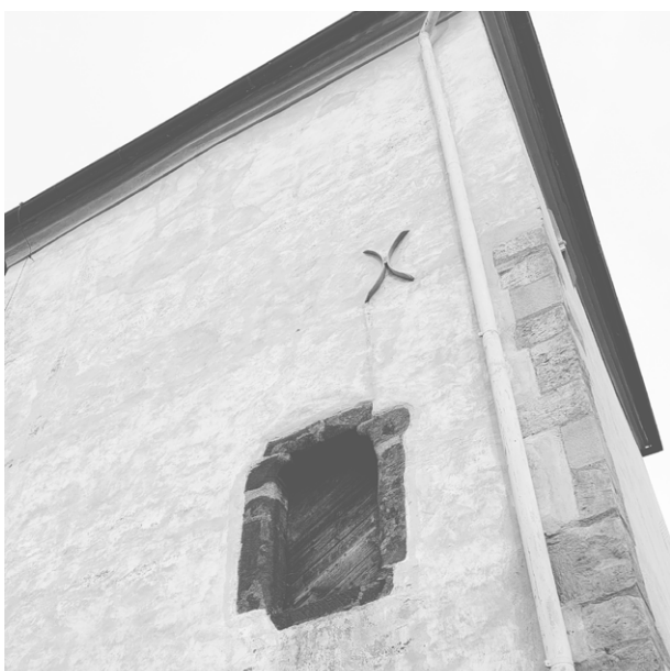
> detail západního průčelí s upraveným raně gotickým vstupním portálkem do patra brány...
