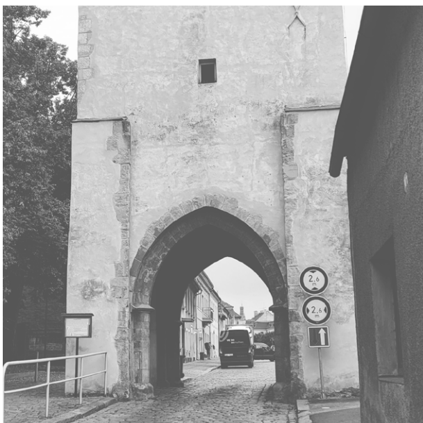
>jižní pohled z ulice Pražská (Okružní) na průjezd Pražskou bránou...
