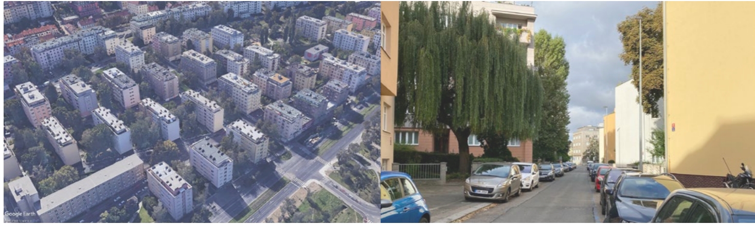
Břevnov - pěti-podlažní bytové domy se společnými zahradami
