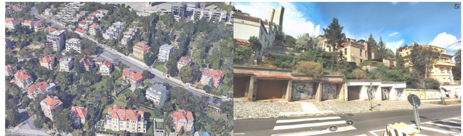
Smíchov (na Hřebenkách) - vily a bytové (terasové) domy v soukromé zahradě
