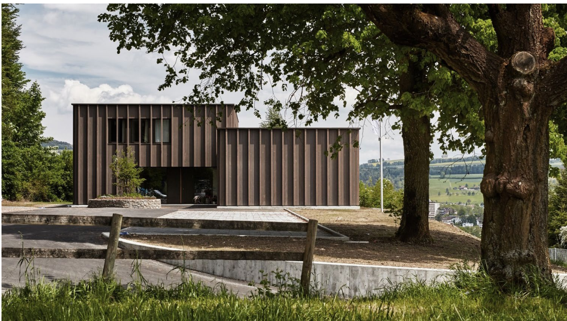
Obr. č. 20: Vstup a okolí porodního domu
