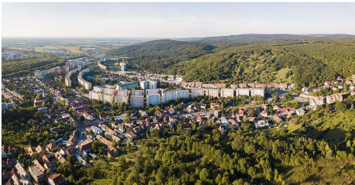
Lamač - pohľad zo Zečáku na severozápad - v popredí centrum Lamača, v pozadí vľavo Bory
