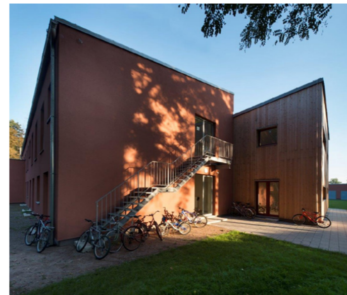
Foto - pohled na místo styku dvou hmot
