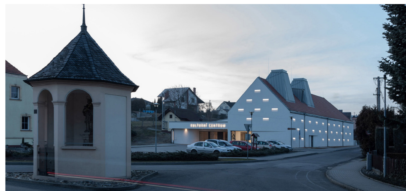
Foto - pohled na kulturní dům z křižovatky ulic Opavská a Hůrecká
