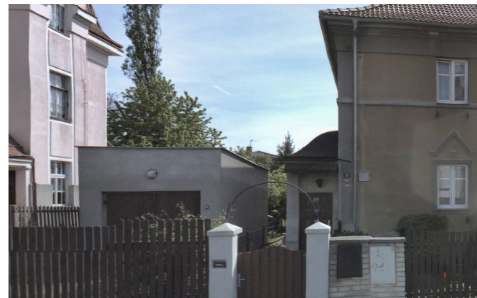
garáže u RD
