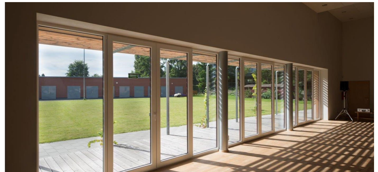
Foto - pohled na místo styku dvou hmot
