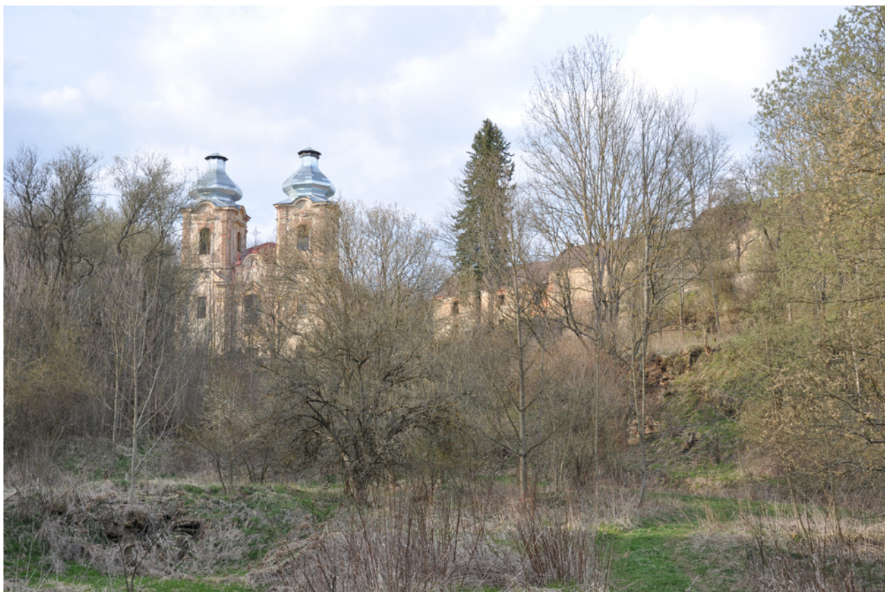
6 - Prostor návsi pod kostelem je v současné době zarostlý náletovými dřevinami.
