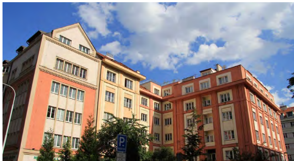
Industrial Holešovice. Source: www.prahaneznama.cz
