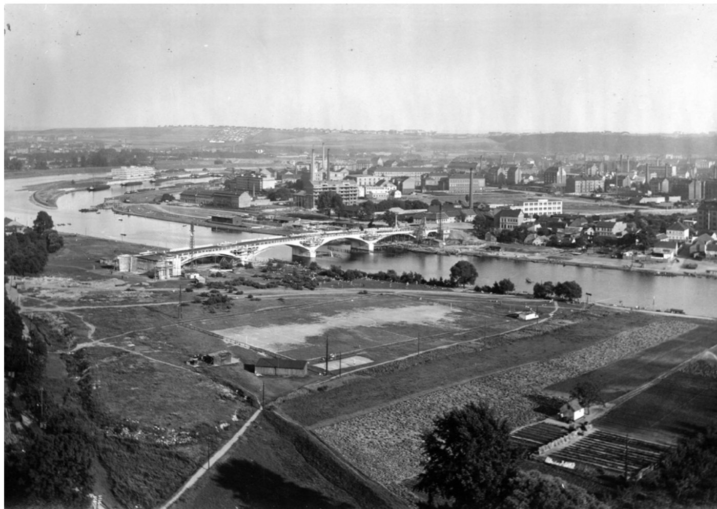
pohled na výstavbu Trojského mostu (1928)
