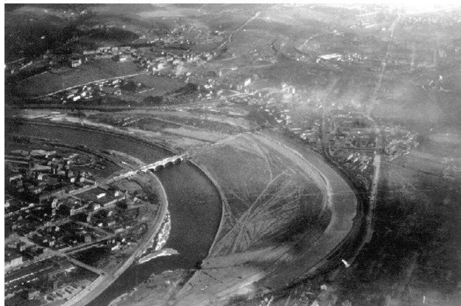
úpravy koryta Vltavy s výstavbou Libeňské mostu (1923—1927)
