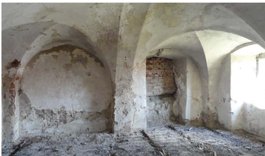
Obr. 26: Prízemie obytného krídla sýpky.
