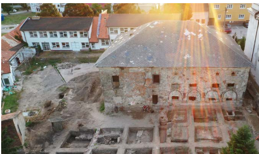
Obr. 22: Pohľad na kláštornú sýpku z východu. V obvodovej stene sú viditeľné ostenia arkád stredovekého ambitu. Za sýpkou je novodobá budova školy.
