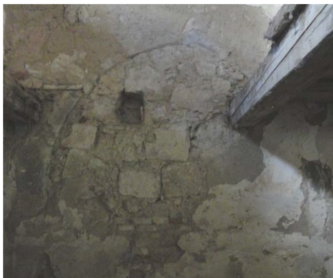
Obr. 48: Arkády v deliacej stene medzi sýpkou a chodbou
