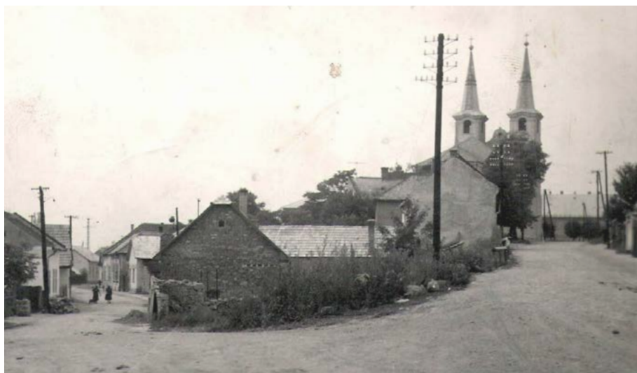
Obr. 17: Pohľad do Školskej a Ipeľskej ulice tesne pred jej asanáciou.
