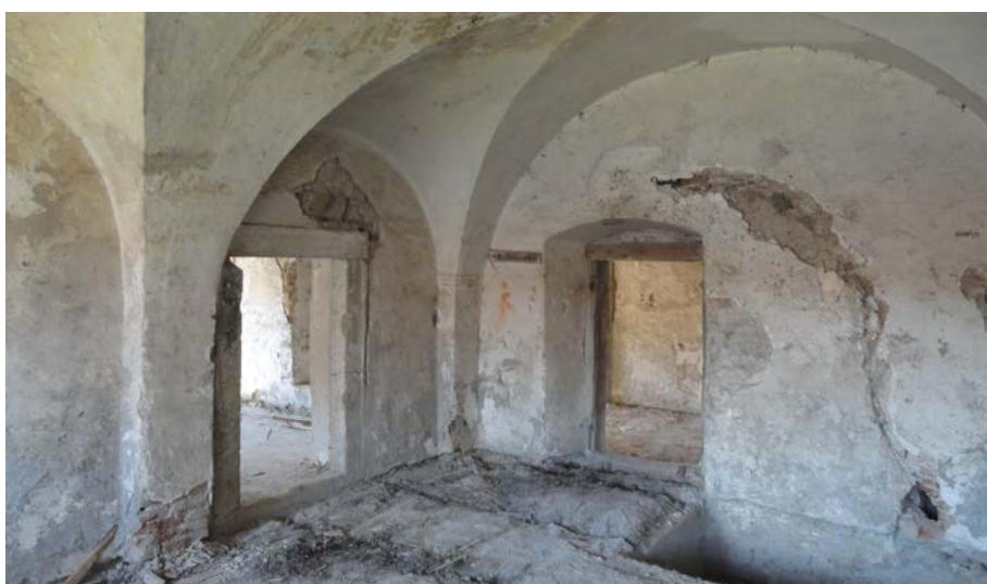
Obr. 28: Prízemie obytného krídla sýpky.
