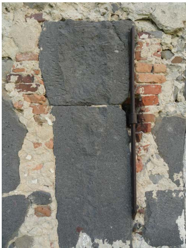
Obr. 46: Obrys nábehu klenby
