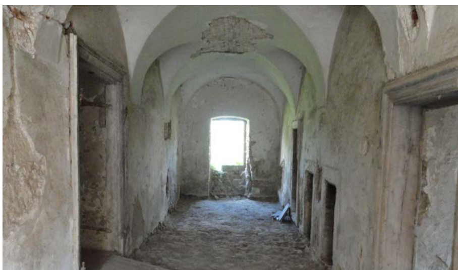
Obr. 27: Chodba na poschodí sýpky
