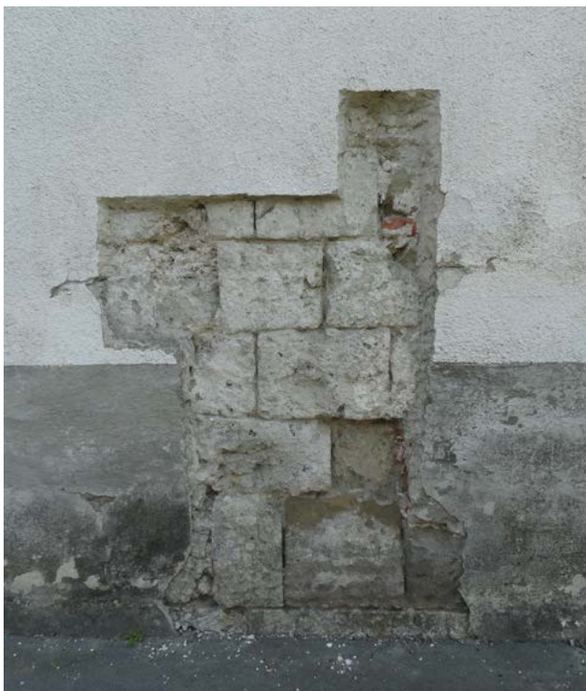
Obr. 35: Románske kvádkové murivo v sonde na severnej stene kostola
