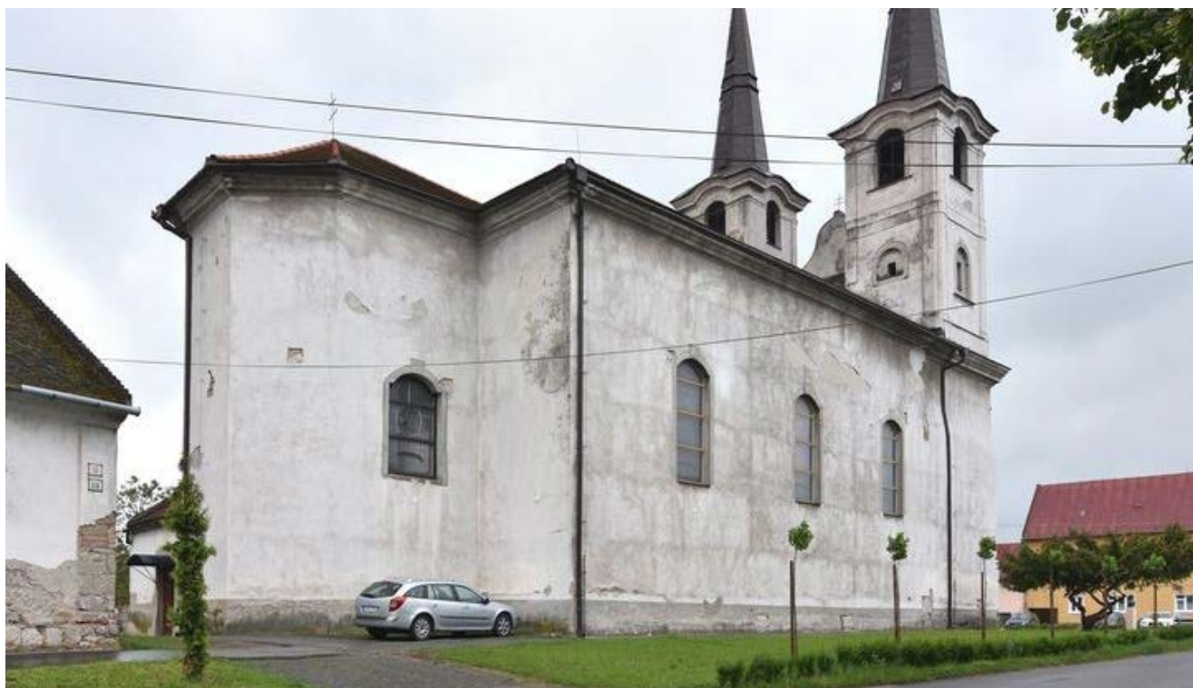
Obr. 32: Pohľad z exteriéru na tvar presbytéria kostola
