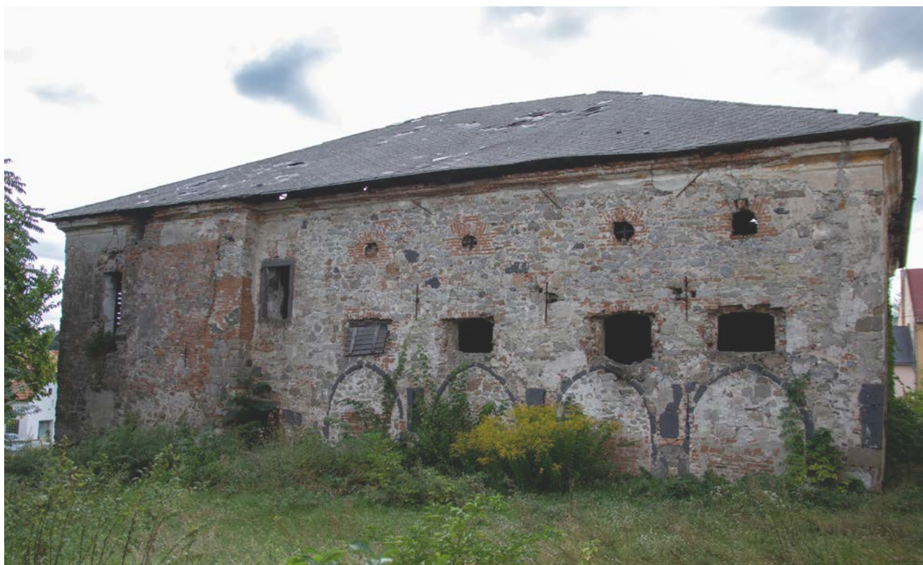
Obr. 43: Pohľad na východnú fasádu sýpky s viditeľnými gotickými arkádami kláštorného ambitu
