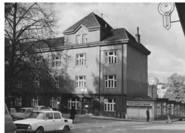
jihovýchodní nároží soudní budovy, 1979
