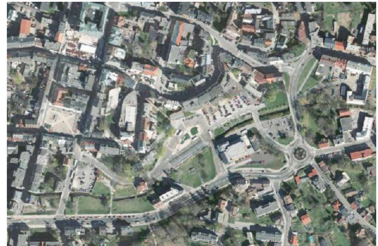
Rok 2015: Objekty podél hlavní ulice 5. května prošly na počátku 21. století demolicí a ulice byla rozšířena. Pod mrakodrapy zůstává autobusové nádraží a parkoviště.
